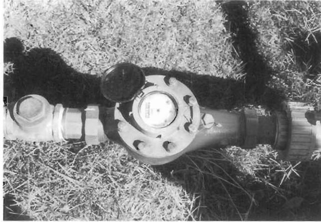
Figura 9. Contador instalado en una acometida.
