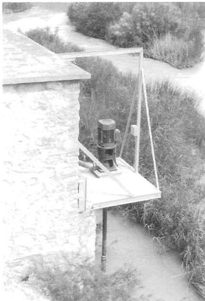
Figura 9. Grupo electrobomba de eje vertical.
