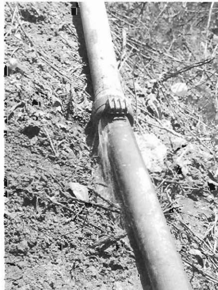
Figura 7. Unión hidráulica entre dos ramales de aspersión.
