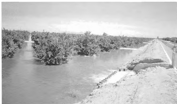
Figura 3: Estructura para evitar la erosión en cabecera consistente en dados de hormigón situados en la entrada de agua.
