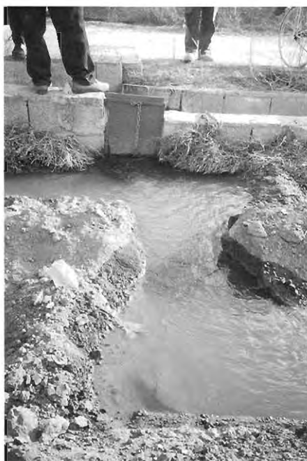
Figura 8. Compuerta para regular el caudal desde una acequia hasta la parcela.
