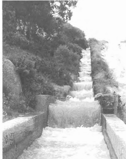
Figura 12. Salto construido para salvar una pendiente excesiva en un canal.
