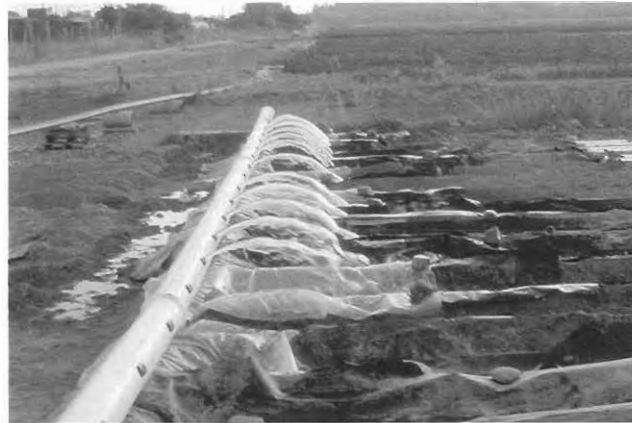
Figura 13. Alimentación de los surcos mediante una tubería rígida portátil. Obsérvese las protecciones de plástico colocadas en cabecera de los surcos para evitar erosión del suelo en la zona de impacto de los chorros.
