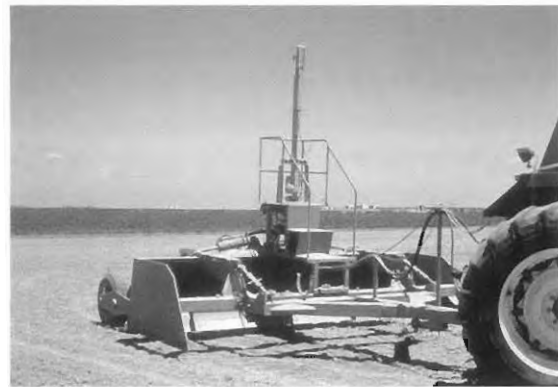
Figura 5. Conjunto formado por niveladora y sistema receptor de láser, tirado del tractor.
