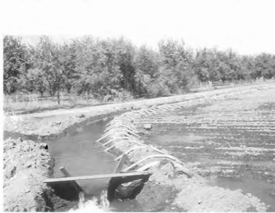
Figura 10. Barrera en una acequia con objeto de mantener un nivel de agua adecuado.
