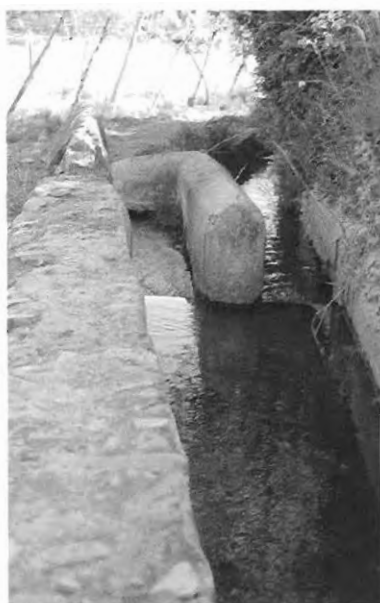
Figura 6. División y distribución del agua de una acequia mediante un partidor.
