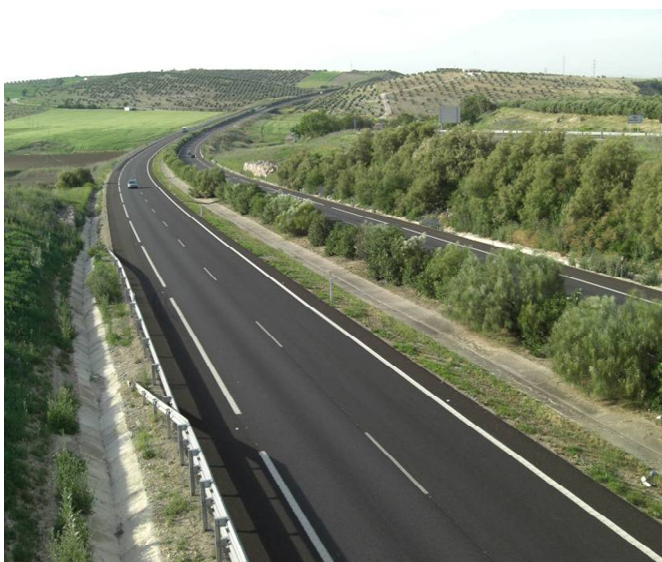
Autovía A-44 Bailén-Motril
