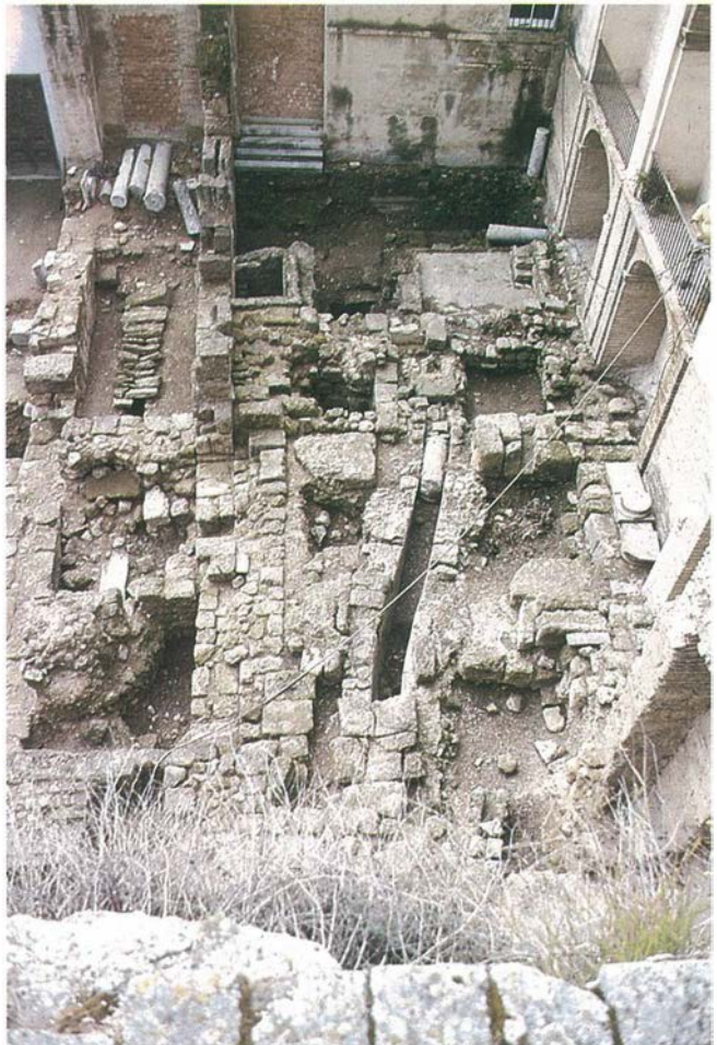
Alcázar Reyes Cristianos. Limpieza de excavación como apoyo a restauración.
