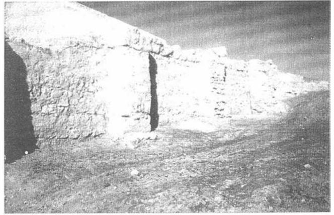
LAM. III. Adaptación topográfica del paramento externo del muro oriental, reforzado por la adición de contrafuertes.
