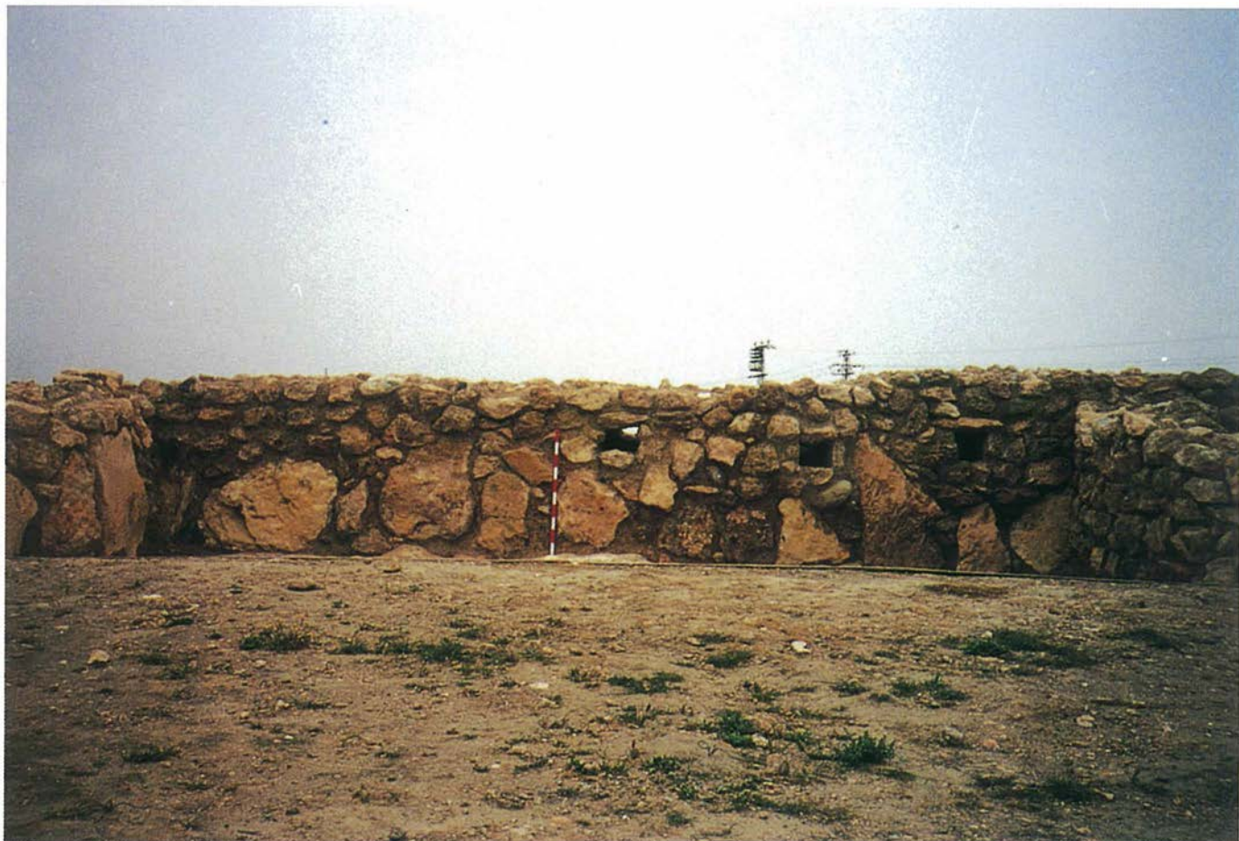
Obra de emergencia en el yacimiento arqueológico de "Los Millares", Santa Fe de Mondújar, Almería. Consolidación y restauración de la segunda muralla.
