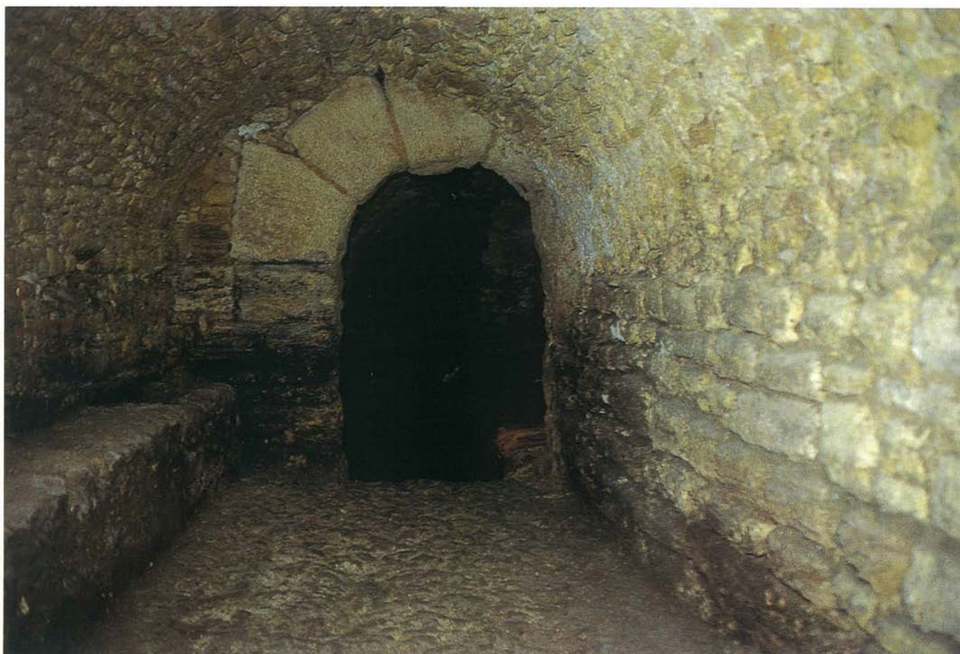
Estructura I de las galerías de agua subterráneas. Medina Sidonia (Cádiz)
