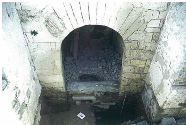
Castillo de Tarifa. Intervención de apoyo a la restauración.
