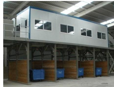
Una buena práctica puesta en marcha en algunas de las empresas del sector consiste en aislar a la cabina del ruido exterior. Para ello se adquieren cabinas que han sido construidas con material con alto coeficiente de aislamiento acústico, de forma que los trabajadores quedan expuestos solo al ruido generado en el interior.
