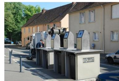
Una vez que han sido elevados, los operarios manipulan los contenedores hasta el sistema de elevación y vaciado del camión de recogida.
