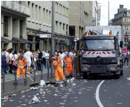
La presencia de operarios en las proximidades del radio de acción de la barredora es un riesgo que aparece en el barrido mixto, factor que se agrava si el trabajo es realizado de noche, por la falta de visibilidad. El personal ha de trabajar en el radio de visión del conductor de la barredora y, en la medida de lo posible, barriendo de cara al tráfico si los trabajos se desarrollaran en vías
