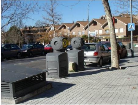
Desde la planta de recogida se acciona el sistema, aspirando cada una de las fracciones de forma independiente. Los residuos son separados de la corriente de aire mediante un separador rotativo y un ciclón, de forma que el aire se lleva a un sistema de filtros y los residuos a un compactador. Una vez compactados los residuos, se acumulan en un contenedor metálico. Una vez lleno, se carga en un camión y se traslada a la planta de tratamiento.
