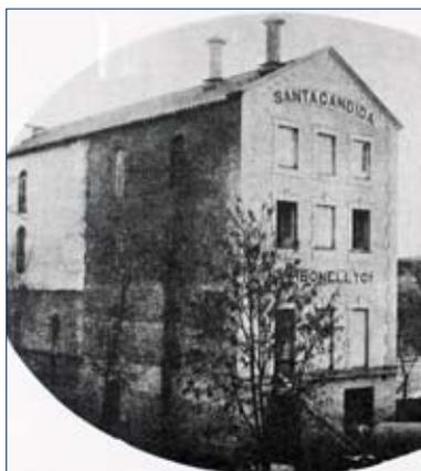
“... consta de una sola crujía para las tres piedras que abraza, construida de fábrica por tres de sus lados, y de madera el cuarto, así como también su cubierta, ... boquerón cuyo muro o puerto es de la misma fábrica, parte de una azuda o presa en dirección a la casa construida a poca distancia de la margen de poniente, la cual está formada de pilotages encadenados formando cajas que están rellenas de piedra suelta del mismo río y su paramento empedrado con sillares
