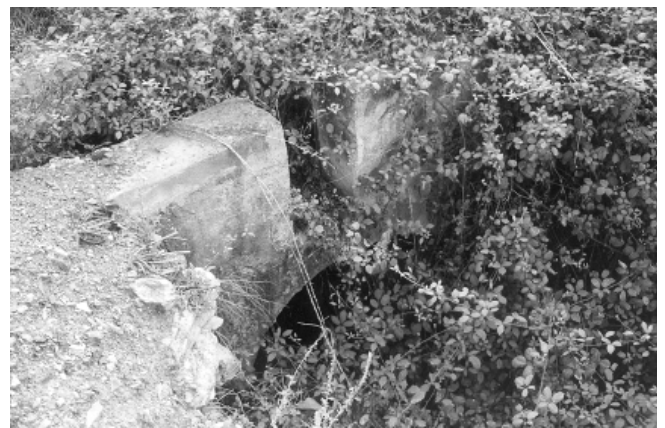
LÁM. II: Detalle del aliviadero de los cubos y salida de la acequia de Anaya.
