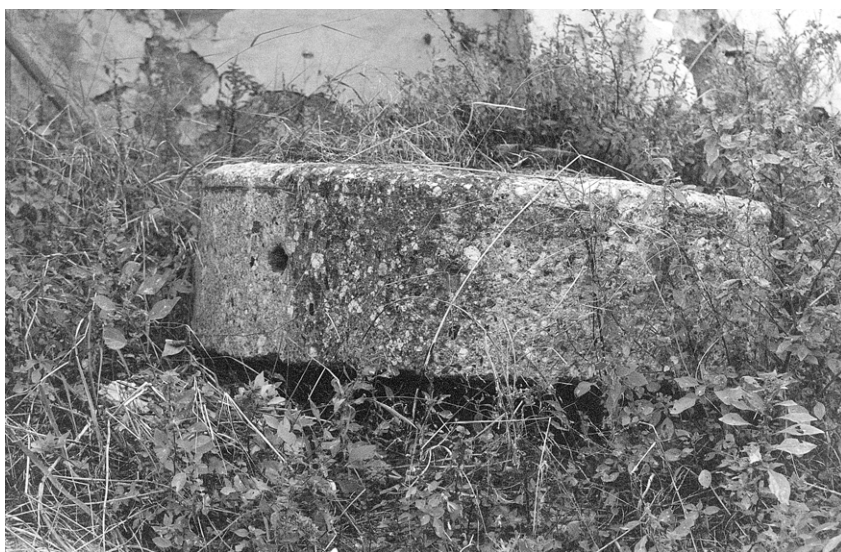
LÁM. IV: Vista lateral de una muela corredera o volandera. Detalle del agujero donde la cabria se sujetaba para el levantado y picado.
