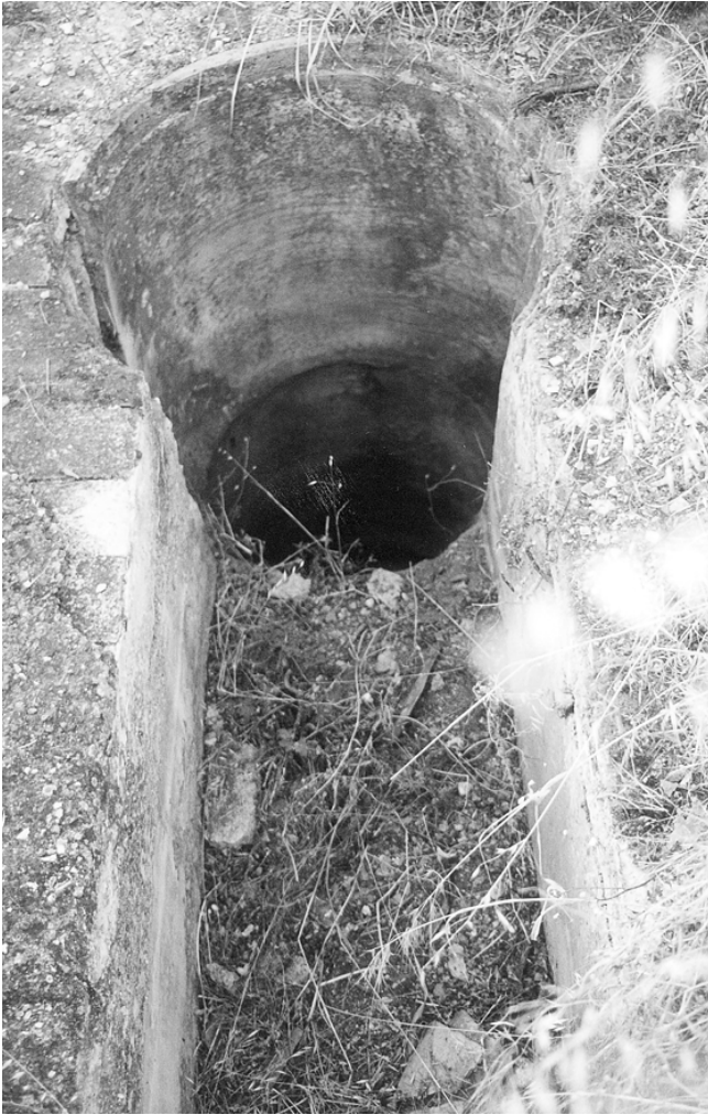
LÁM. III: Detalle de uno de los cubos. Pueden observarse los atadores de cerámica.
