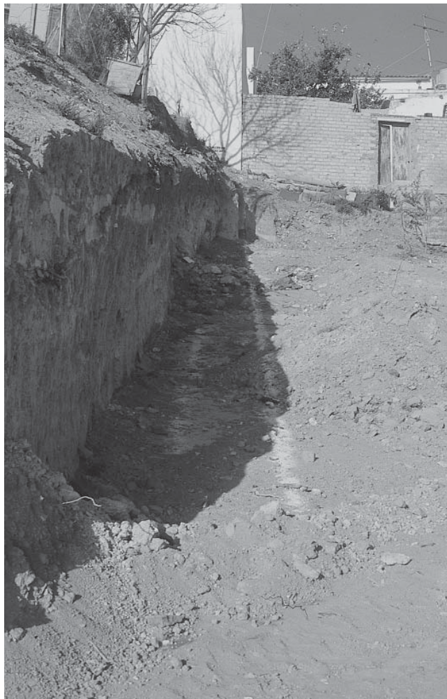
LÁM. VII. Seguimiento de las obras de acceso al parque público del Cerro Mariana.
