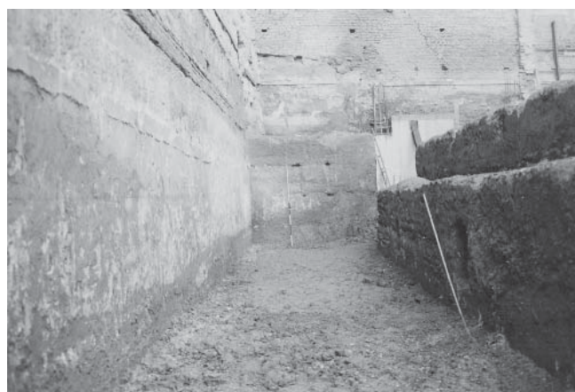
LÁM. II. Vista general de las estructuras defensivas: lienzo de muralla, antemuro y torre
