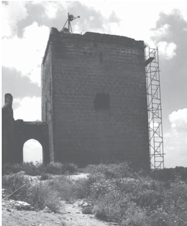
LÁM. I. Vista general de la Torre 1 y puente de conexión al Castillo.
