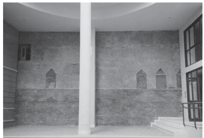
LÁM. III. Lienzo de muralla tras el proceso de restauración
