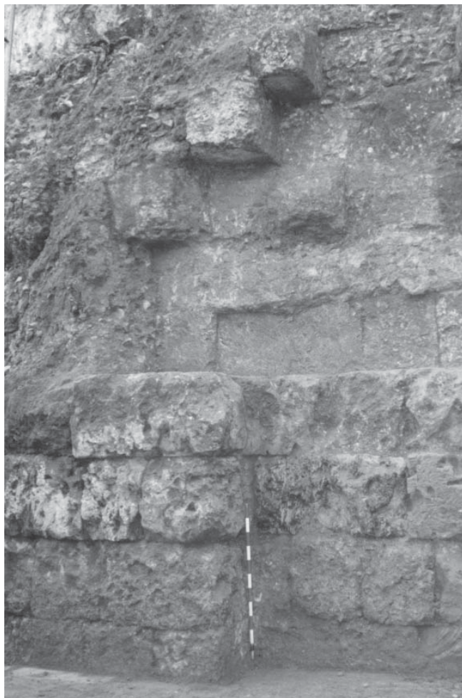
LÁM. I. Detalle del MT2 de la estancia 2 en el que se aprecia el expolio de los sillares de opus quadratum.
