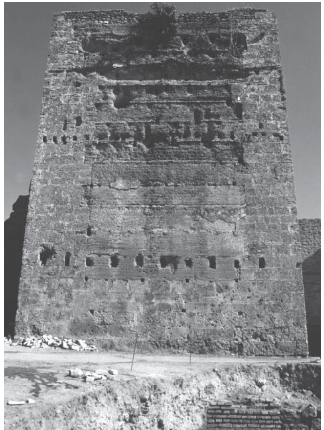
LÁM. V. Frontal de la torre colindante, en donde se aprecia la huella de los distintos niveles de mechinales correspondientes a forjados.
