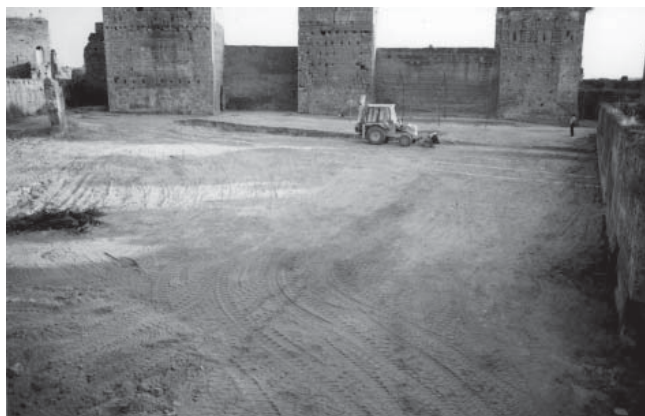
LÁM. I. Rebaje de la primera terraza de gradas para construcción del auditorio.
