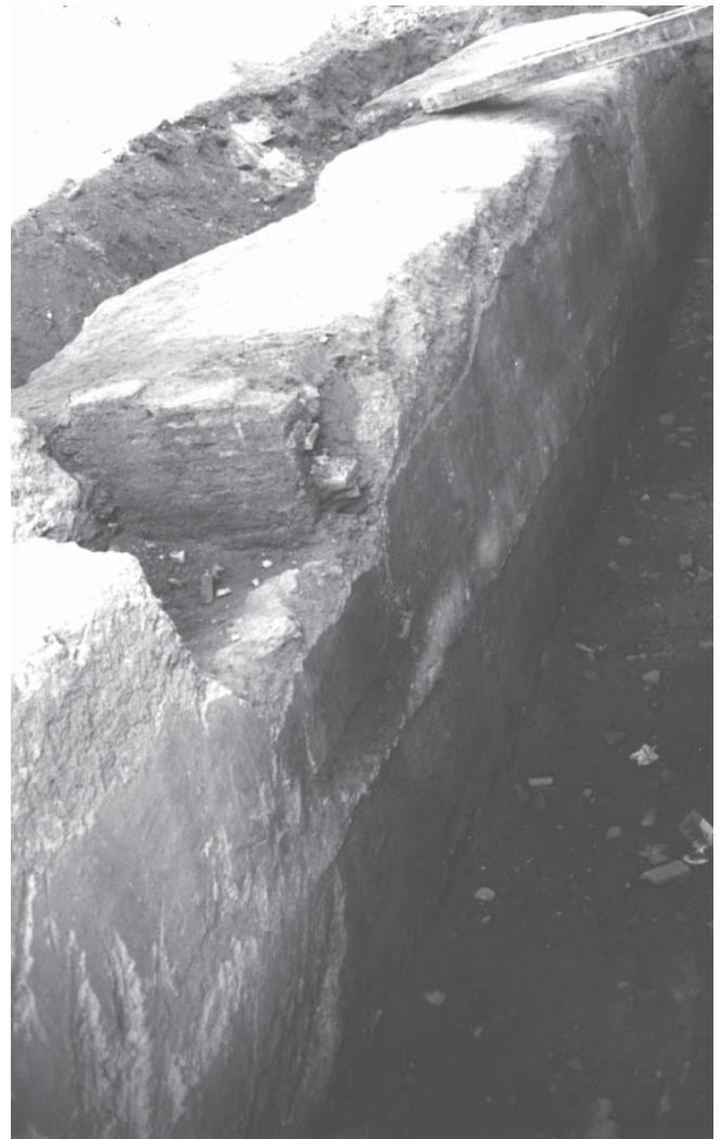
LÁM. II. Vista general del alzado interior de la muralla
