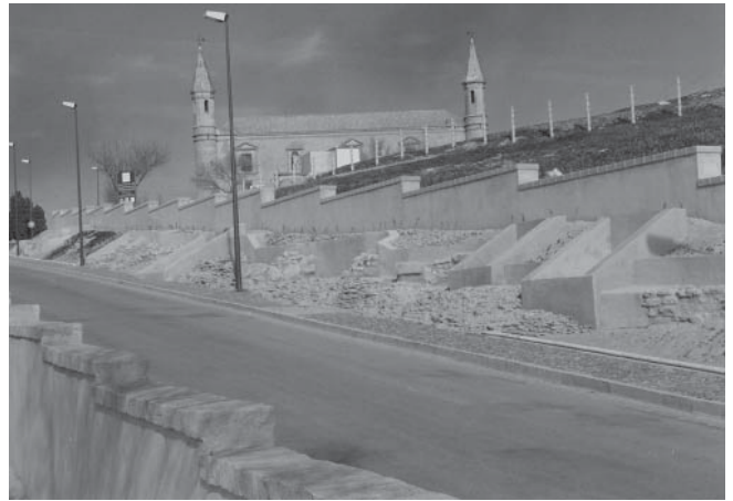
LAM. V. Estado final de la calle.
