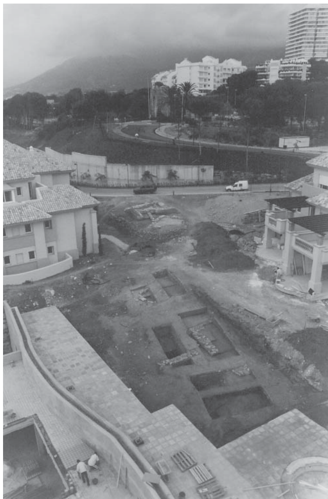
LAM. I. Panorámica general de la intervención.
