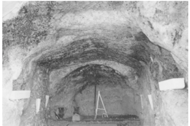
LÁM. II. Interior de la Ermita del Almendral, con el techo y paredes labrados.
