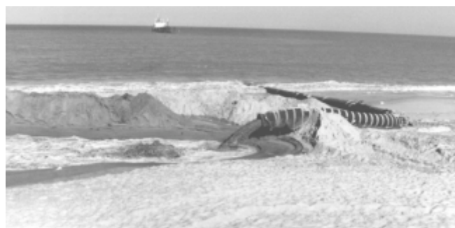
LÁM. III. Descarga de la arena en la playa por impulsión con agua.
