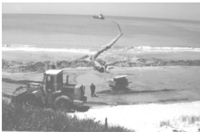
LÁM. II. Panorámica del proceso de vertido de arena: draga fondeada, tuberías, caballón de arena y pala retro-excavadora.
