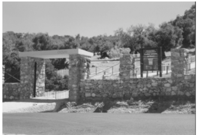
LÁM. V. Cerramiento, vallado y portada del acceso al yacimiento.
