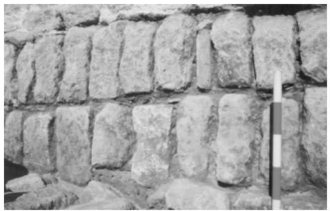
LÁM. III. Detalle de la cimentación de la muralla, a base de sillares atizonados.
