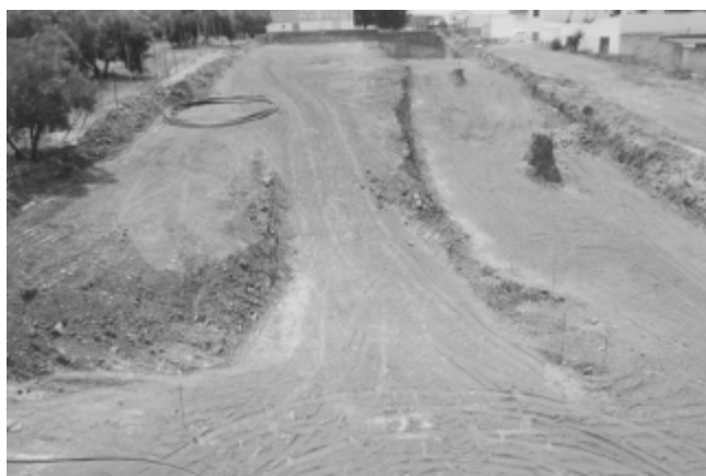
LÁM. I. Vial de la urbanización y parcela sobre la que se desarrolló la excavación.
