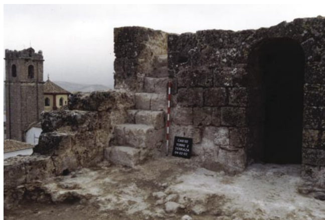
LÁM. V. Torre 2. Terraza. Espécula formada aprovechando el garitón de salida, con las escaleras originales de acceso documentadas durante la intervención.
