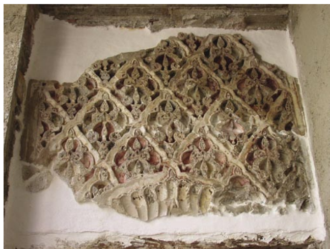
LÁM. V. Nuevas yeserías in situ.
