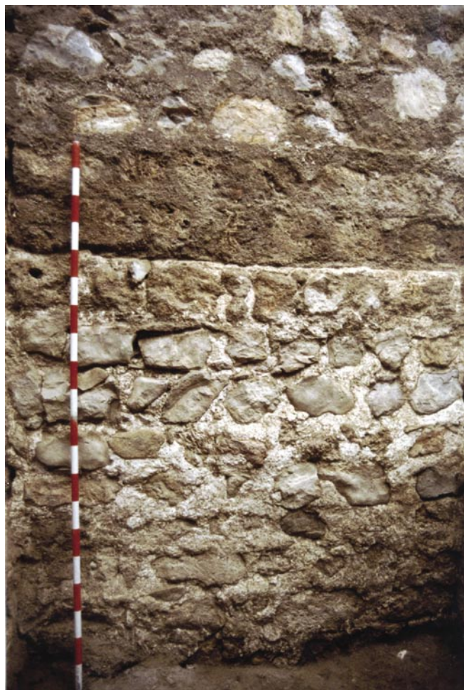
LÁM. IX. Sondeo 15 (Z5). Lienzo 11. Detalle de fase andalusí de época omeya, con mampuestos trabados con yeso, a la que se superpone fábrica bajomedieval.
