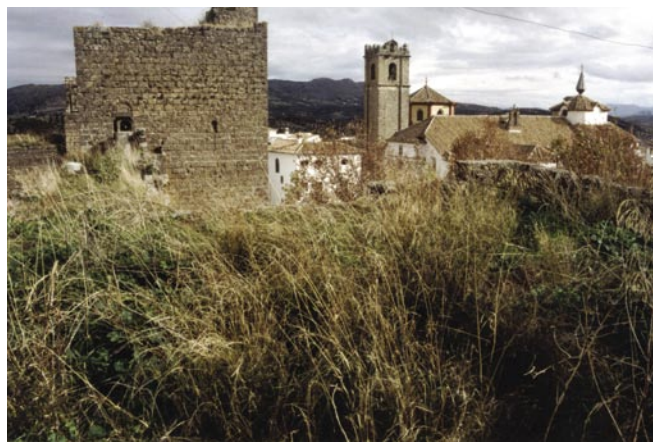
LÁM. III. Torre 1, antes de la intervención.
