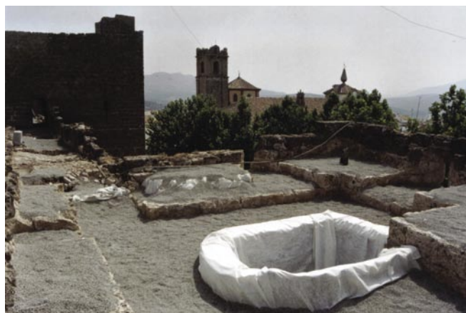
LÁM. IV. Torre 1, después de la intervención, con la protección de geotextil y gravilla.
