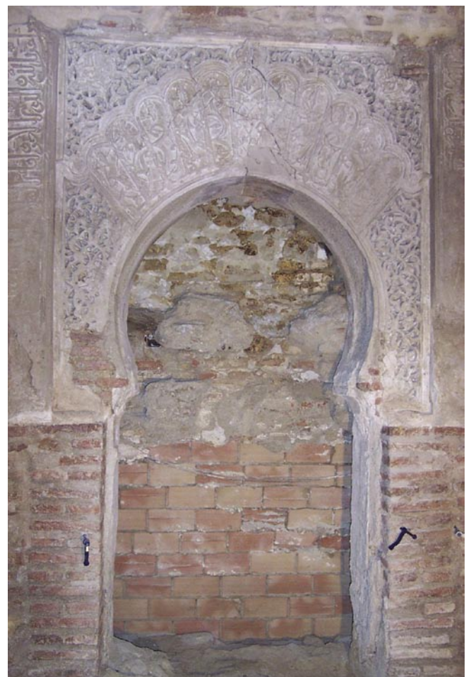
LAM. III. Arco Mihrab después de la intervención de consolidación.
