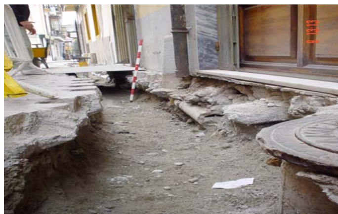
Lámina II. C/ Escudo del Carmen. Zanja de la izquierda. Escalones de acceso a vivienda, canalización de evacuación de atadores cubiertos de tejas, que tras ser sustituida posteriormente con tuberías de fibrocemento, conecta con una estructura circular de unos 0'40 m.
