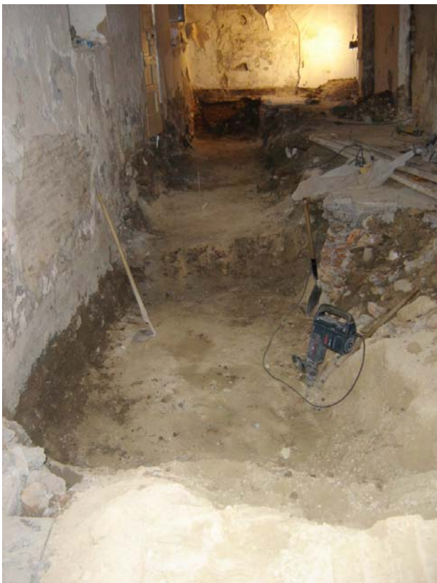
Lámina III. Vista general de la zona de intervención.
