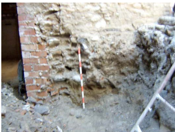
Lámina III. PERFIL DEL MURO DE CARGA.
