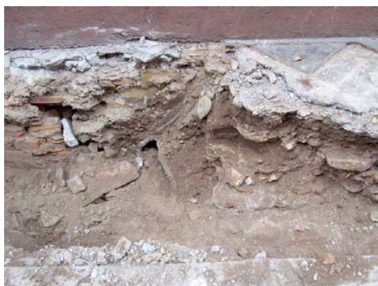
Lámina III. Cimentación de cantos y ladrillos. Tramo 3
