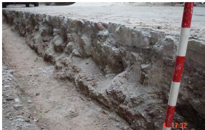
Lámina I. C/ Escudo del Carmen. Zanja de la derecha. Pavimento de la calle sobre una capa de cemento y un nivel de grava de preparación.
