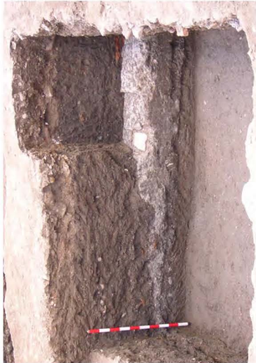
FOTO 02: SONDEO 1, Vista del muro de tapial
