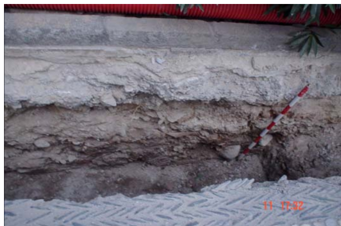
Lámina III. C/ Colcha. Pavimento empedrado de la calle, bordillos de la acera y preparación de cal grasa del pavimento.
