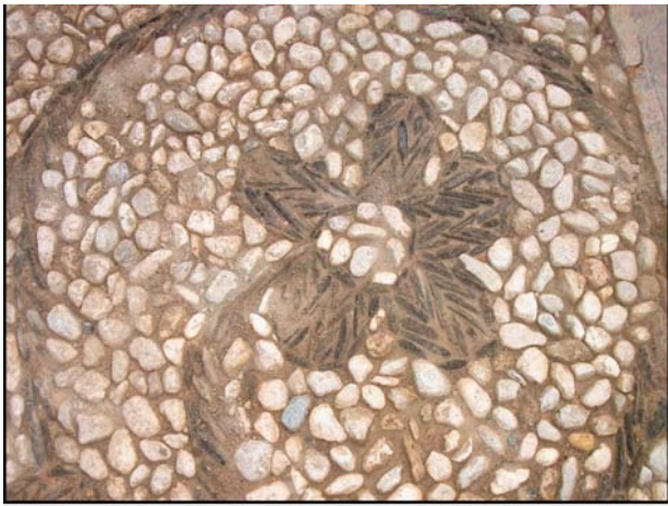
Foto 3. Detalle del empedrado central
