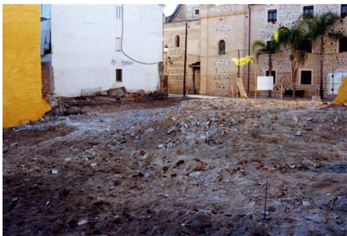
Lámina I. Solar antes de excavar
