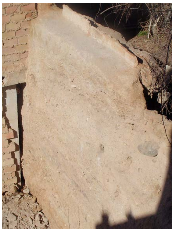
Lámina 5. Vista de la cara superior de la muralla.
