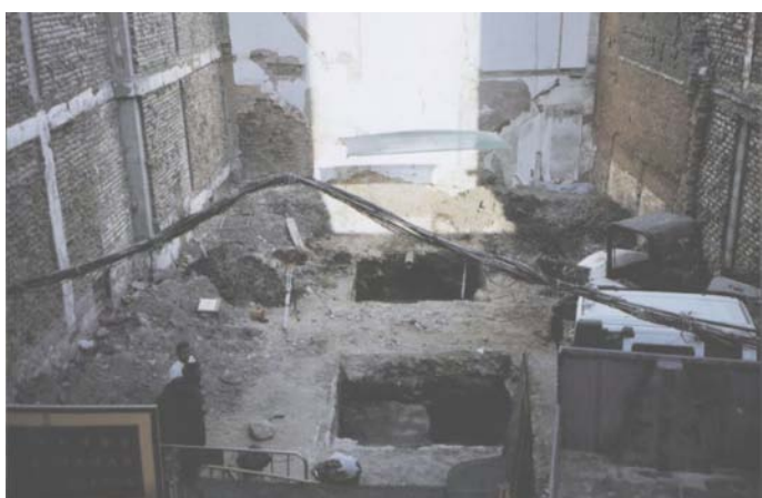
Lámina III. Finalización de la Intervención.
