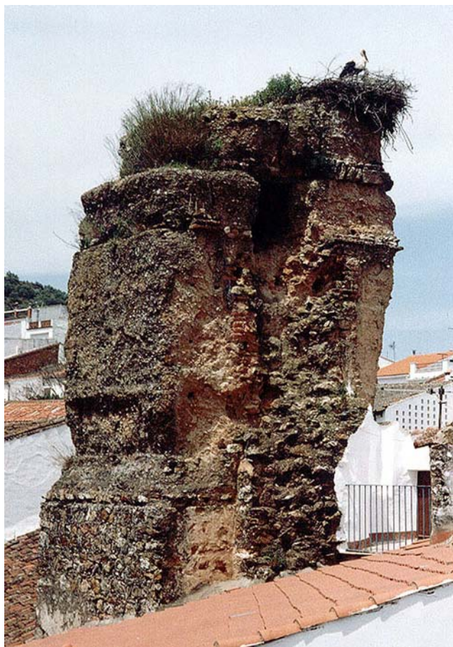
Lámina II. Paramento Este y restos del lienzo de muralla
