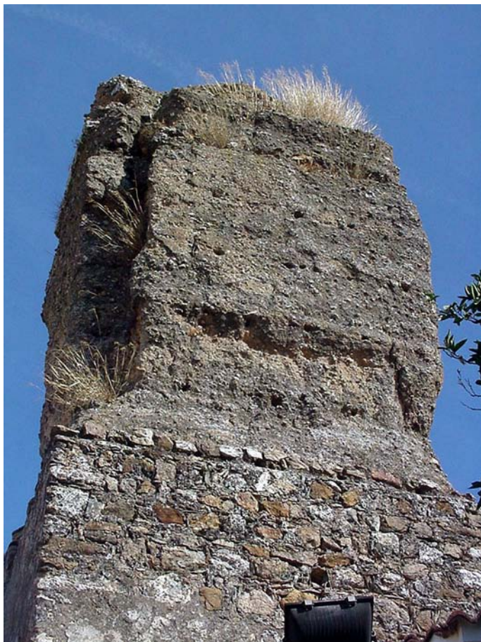
Lámina III. Cara Sur con basamento y fábrica de tapial
