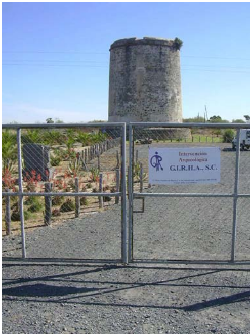
Lámina I. Vista general de la torre almenara.
