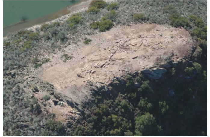
Lámina II. Fotografía aérea de la excavación total.
