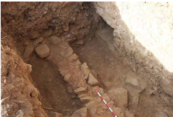
Lámina IV. Detalle del sondaje 2 una vez finalizada la excavación.
