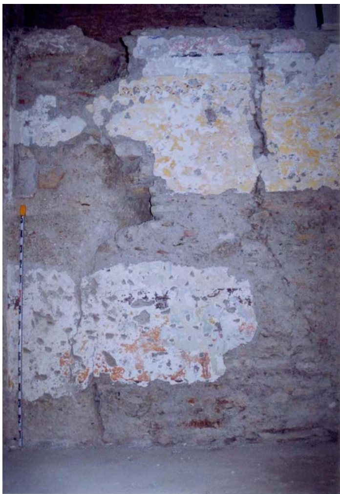
Lámina V. Pared III con la muralla y los lienzos al descubierto después de su limpieza.
