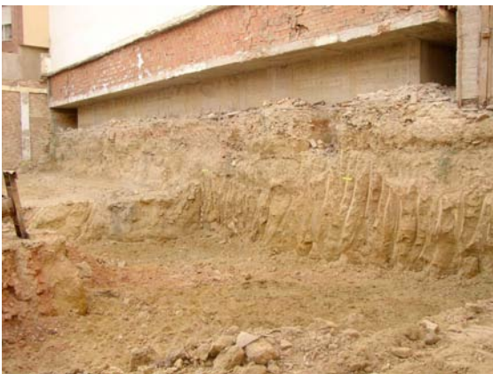
Lámina II. Trabajos de rebaje generalizado en la zona S-E del solar.
