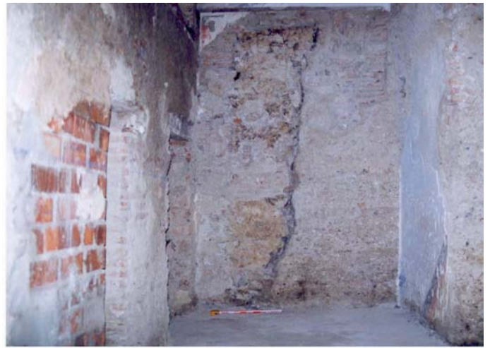
Lámina II. Vista general de la muralla seccionada.
