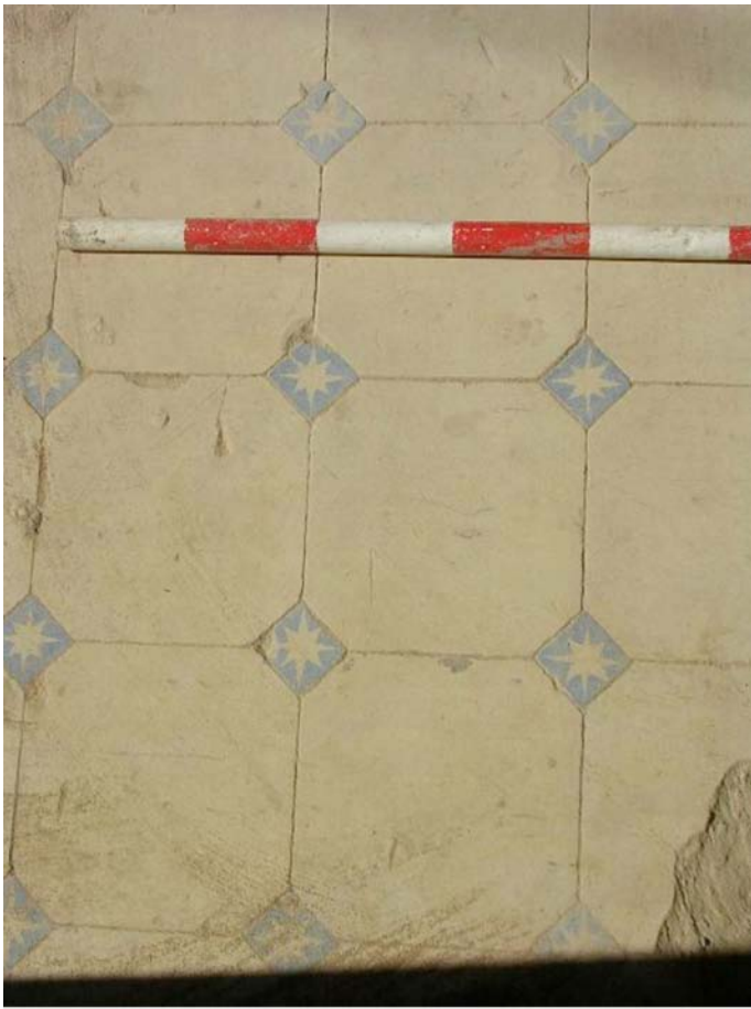
Lámina IV. Detalle de la solería hidráulica
