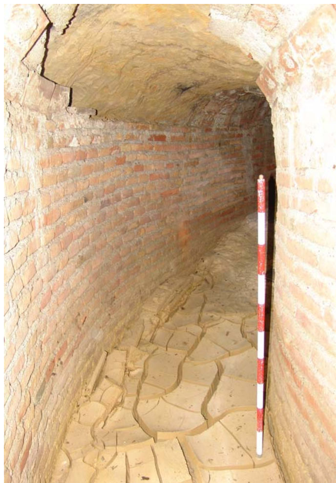
Lámina II. Interior de la estructura con parte del abovedado caído dejando a la vista los niveles geológicos.
