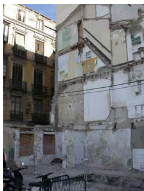
Foto 1. Vista del solar desde el lateral del río Guadalmedina.
