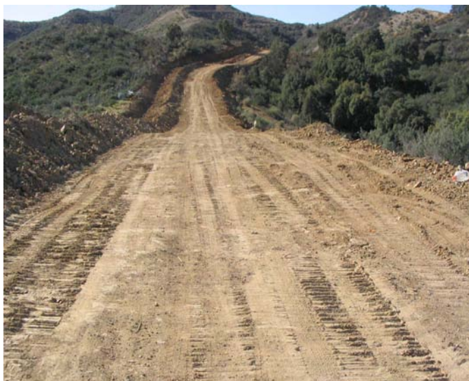
Lámina I. Vista de la pista de trabajo necesaria para la circulación de la maquinaria.
