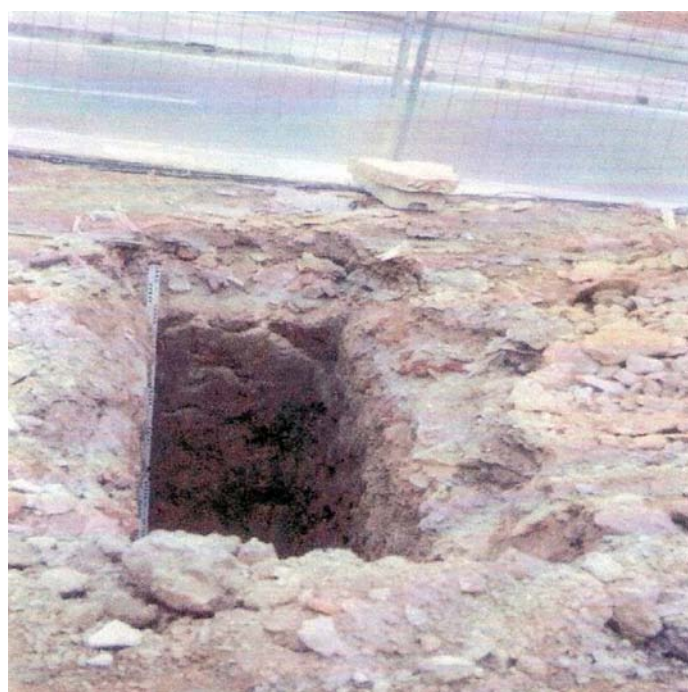
Foto 2. Zanja n. 4 perpendicular a la acera de C/ Postigos, donde se observa la inexistencia de hallazgos relacionados con la muralla mencionada por F. Carter en el siglo XIX.
