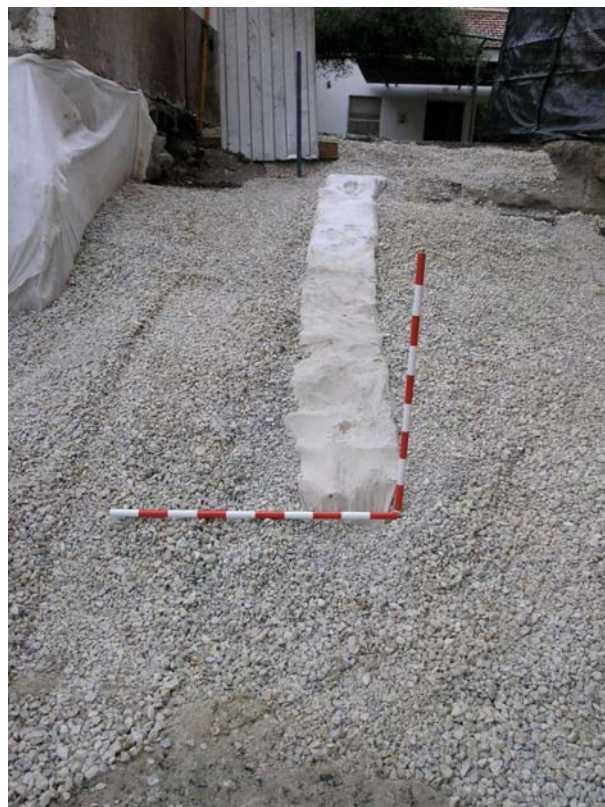
Fotografía 8. Cubrición con geotextil y gravilla.
