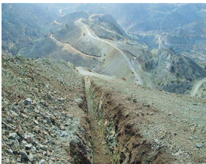
Lámina II. Vista de la Zanja abierta necesaria para la instalación de la tubería.
