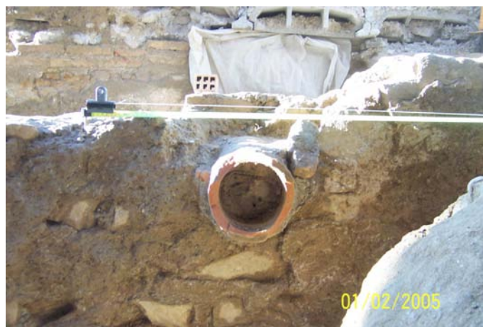
Fotografía 4. Detalle del arranque de la canalización cerámica.
