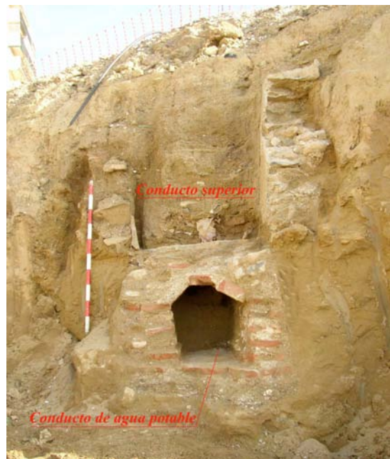
Lámina IV. S4. A escasos metros de S3 se descubre un nuevo tramo transversal a la canalización que mantiene la estructura y fábrica de la misma y, que está orientado hacia una alberca situada a unos metros de distancia
