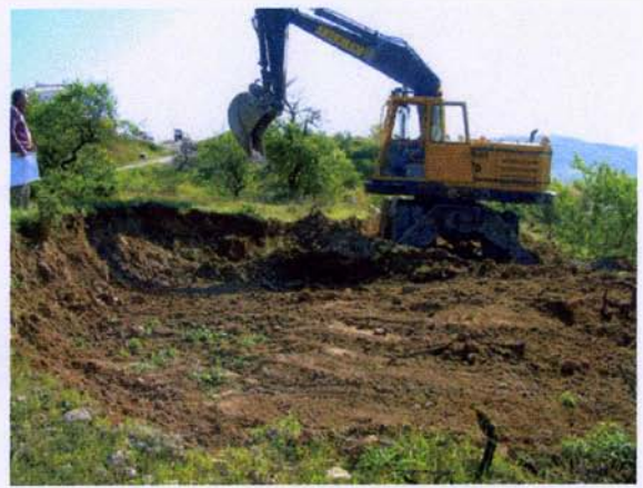
Desarrollo de los trabajos de rebaje.
