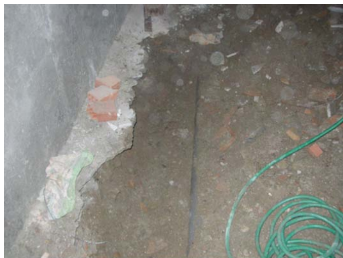
Lámina VI. Vista del saneamiento en funcionamiento
