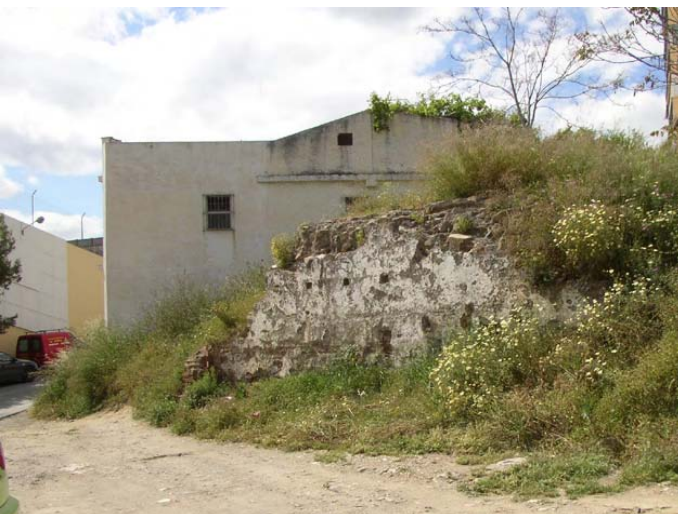
Lámina X. La canalización desemboca en un molino situado a pocos metros de la alcubilla, el cual aparece perfectamente visible a pesar de la abundante vegetación que lo rodea.
