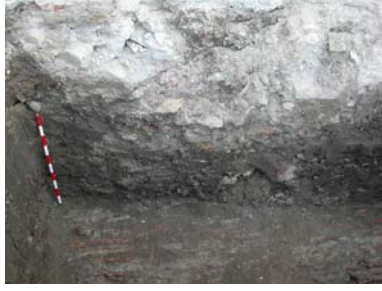
Foto 5. Cimentación, correspondiente a la última edificación existente, fabricada con mampostería y mortero. Apoya directamente sobre la cubierta del colector.
