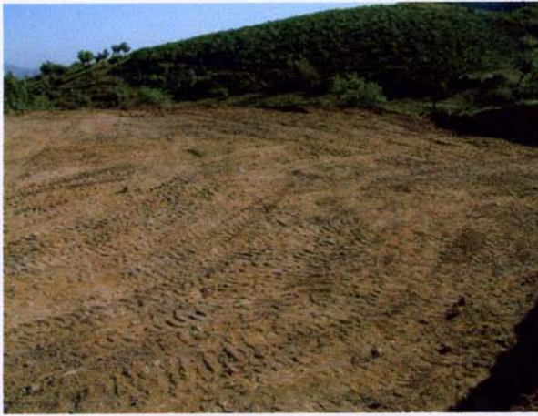
Parcela tras la finalización de los trabajos. Vista N
