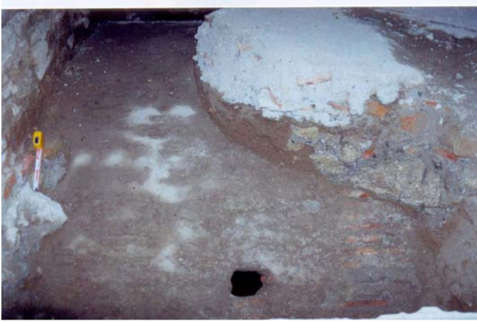
Lámina I. Vista del colector.
