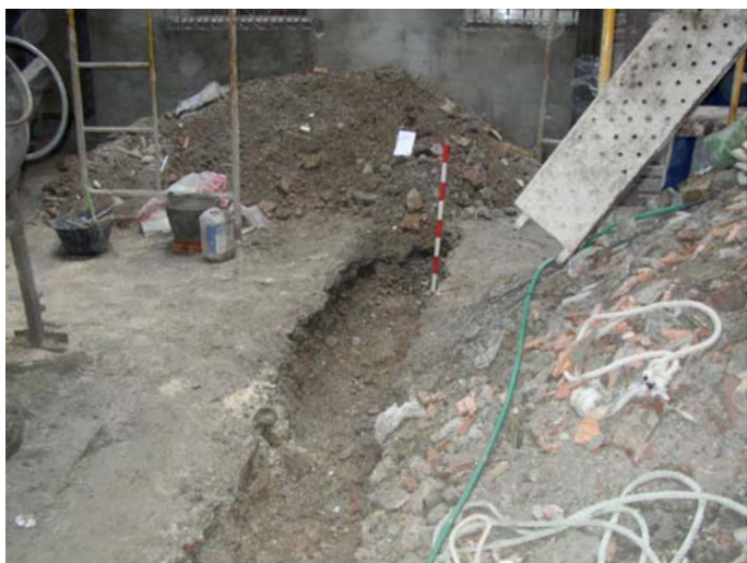
Lámina III. Vista general de la zanja abierta
