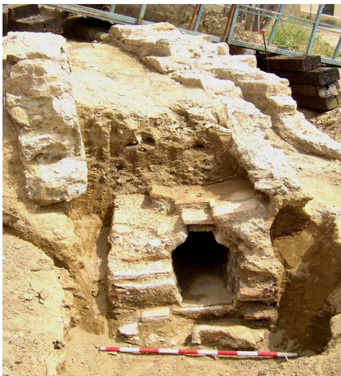
Lámina VII. S5. Inicio de la bifurcación de los dos canales que se desvían tomando cada uno una dirección distinta.
