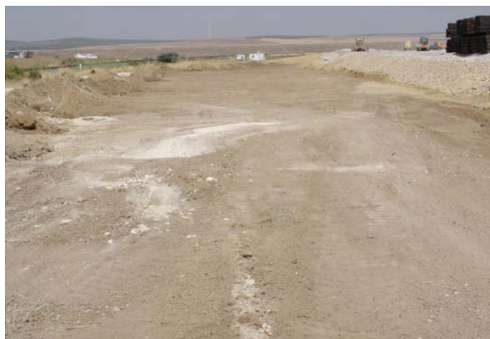
Lámina I. Vista general del desbroce mecánico.
