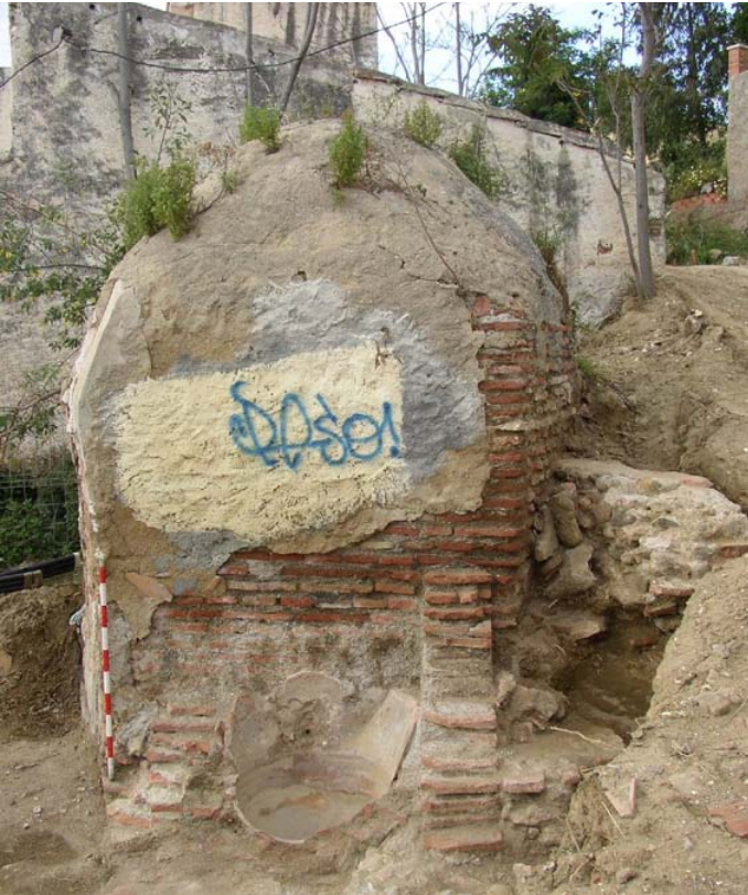
Lámina IX. El conducto de agua potable desemboca en la alcubilla o depósito de agua construida con ladrillos y mortero. Presenta dos salidas en su parte inferior y un pequeño abrevadero de cerámica
