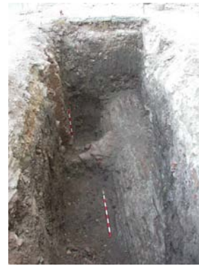
Foto 6. Vista del colector y de la conexión con la alcantarilla. Desde el sur
