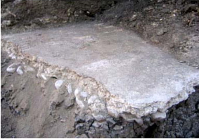
Lámina VII. Detalle de muro y cimentación aparecido en batache.
