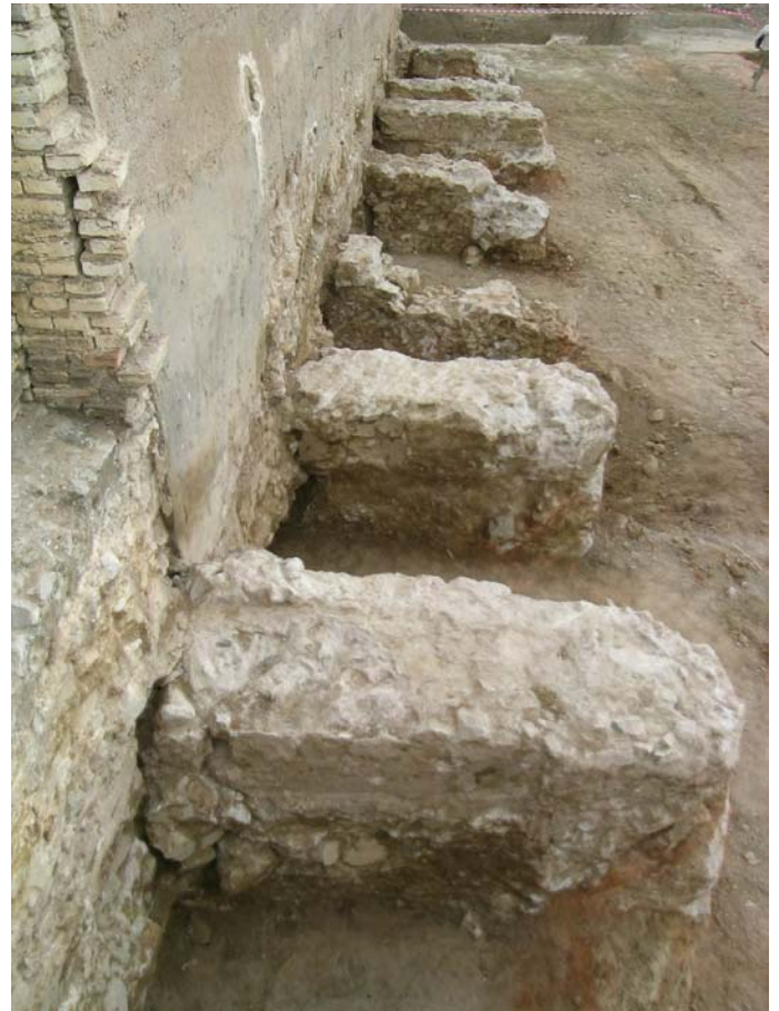
Lámina III. Estribos o contrafuertes de la muralla. El frente de estas estructuras se encuentra impregnado de la arcilla roja del terraplén de época republicana
