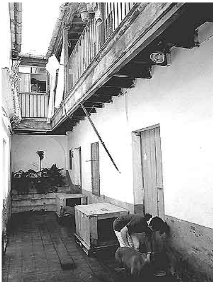
Lámina II. Interior del antiguo corral de vecinos del nº 98 de la calle San Vicente (ver nota 6).
