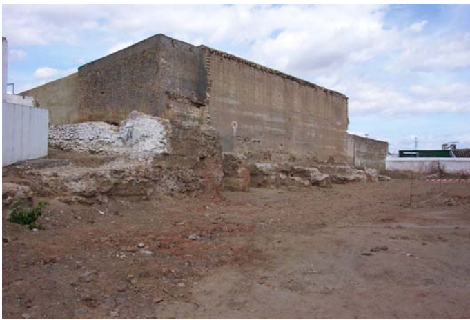
Lámina II. Muralla de opus caementicium en el sector oeste del solar
