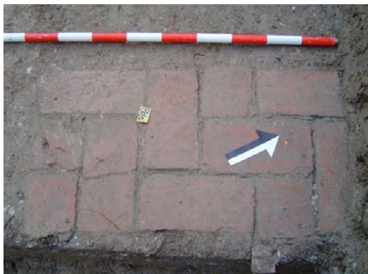
Lámina II. Detalle de UE 148.
