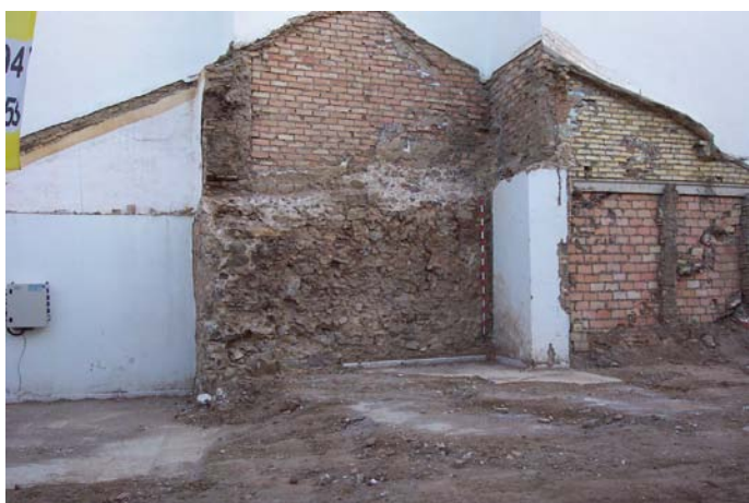
Lámina V. Frente de una de las torres analizadas integrada en los inmuebles nº 80 y 82 de Antonio Reverte.
