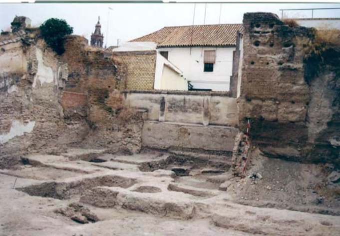
Lámina III. Vista general de los restos del sistema defensivo almohade documentados en la intervención.
