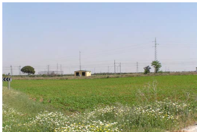
Lámina II. Subestación de Don Rodrigo
