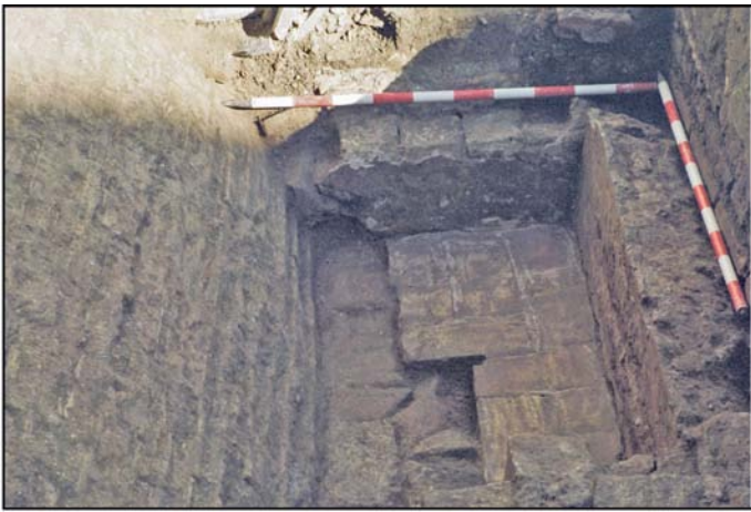
Lámina I. Sector III. Detalle del muro cortado de la pileta en la construcción del aljibe.
