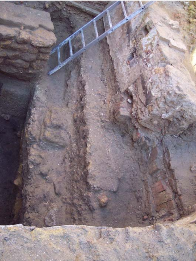
Cimentación escalonada de cronología moderna.
