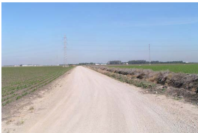
Lámina I. Área de la subestación de Los Palacios.
