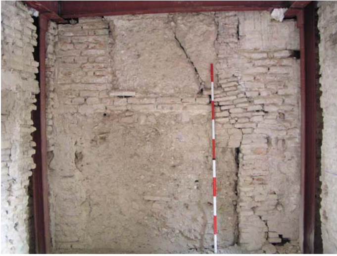
Lámina V. Limpieza del muro medianero M-2.
