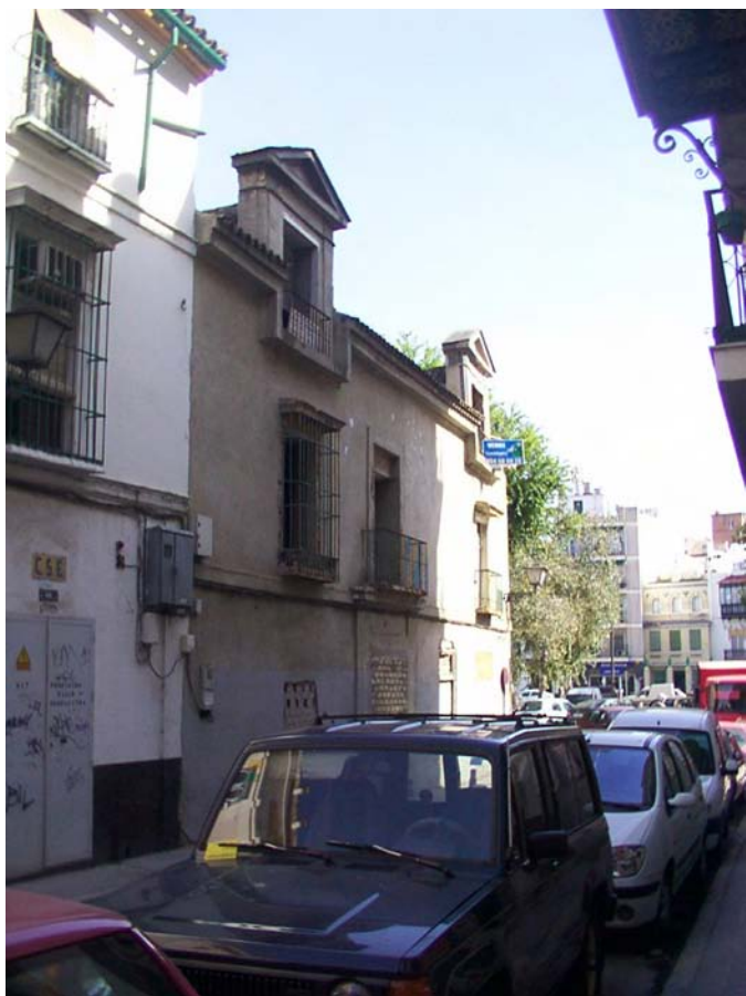
Lámina I. Fachada a calle Santa Ana.
