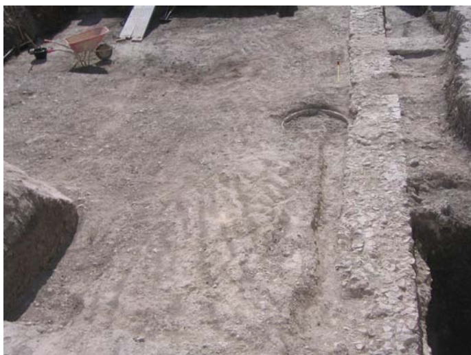
Lámina I. Infraestructura romana y preparación de gravas y cal en su lado Este.
