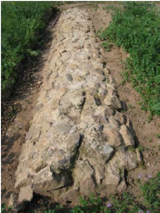
Lámina IX. Acueducto de Valdepuentes. Bóveda de opus caementicium.
