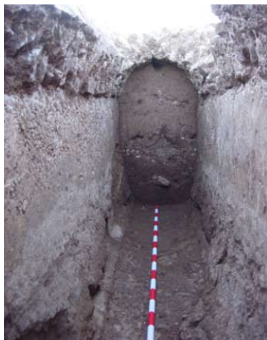
Lámina III. Interior del acueducto con el cuarto de caña en las aristas inferiores
