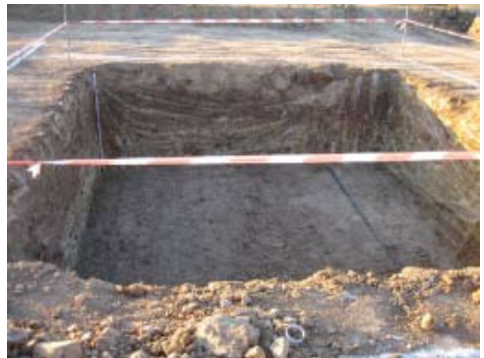
Lámina III. Sondeo para grúa. Zona Oeste
