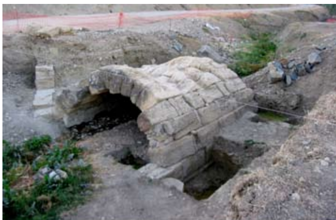
Figura 6. Vista del puente al finalizar la intervención.
