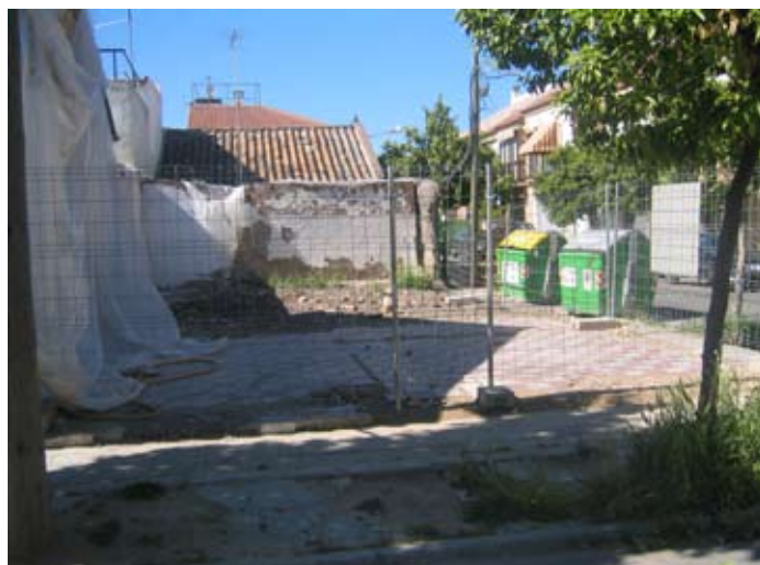
Lámina I. Solar visto desde el Sur
