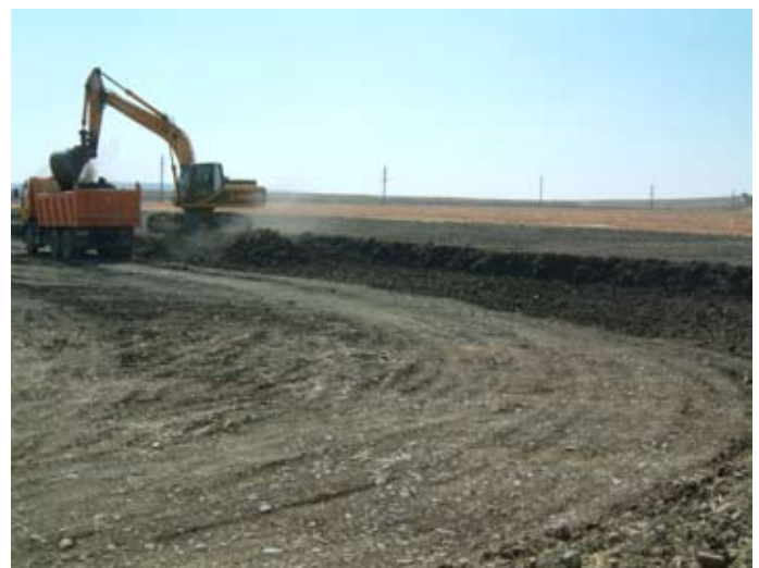
Lámina III. Detalle de excavación de la parcela sobre terrenos naturales.
