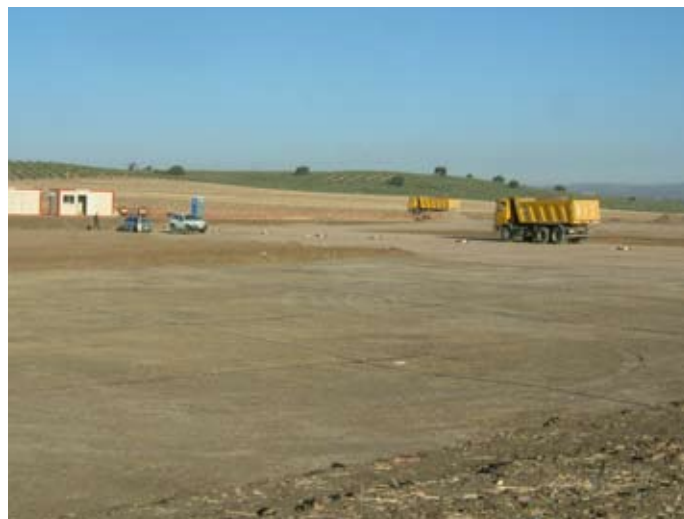
Lámina I. Trabajos de compactación del material aportado.
