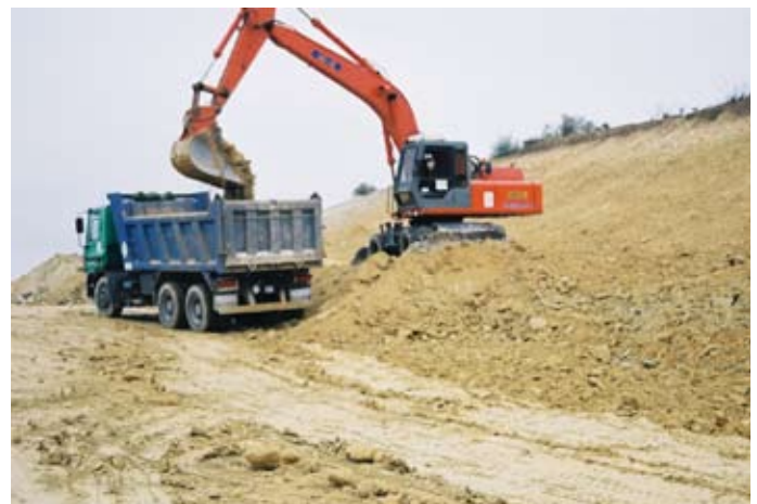
Lámina V. Desmonte 5. Proceso de excavación.
