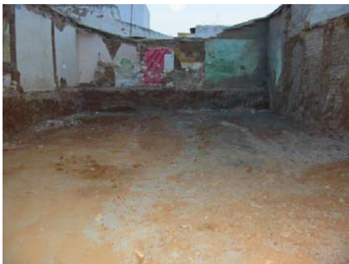
Lámina I.- Vista del solar antes de la excavación, orientación Sur-Norte.
