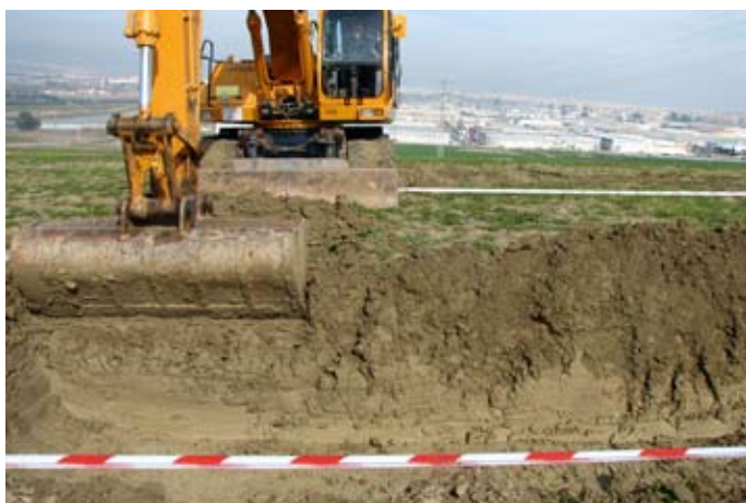
Lámina III. Excavación mecánica del sondeo-04 del área I (cañuelo alto I).
