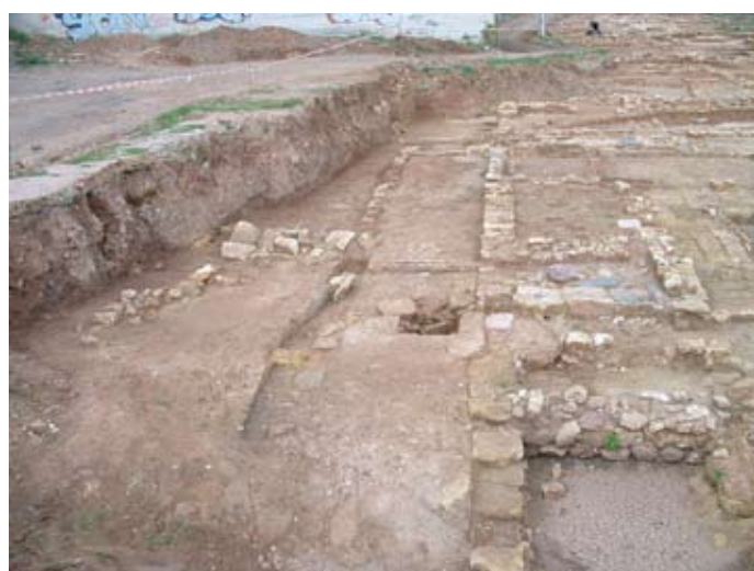
Lámina IV. Calle A. Atarjea central U.E. 398 y derrumbe de fachada U.E. 399 (izquierda). A la derecha la vivienda 1.
