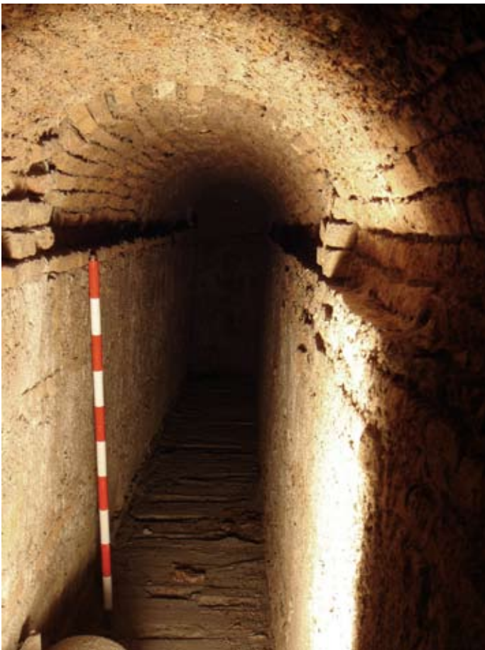
Lámina V. Sondeo 1. Canalización moderna U.E. 16.
