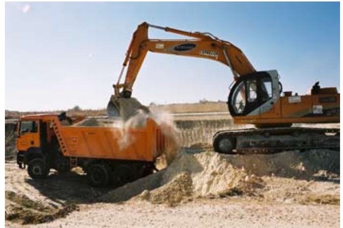
Lámina IV. Desmonte 4. Proceso de excavación.
