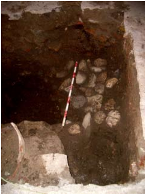
Rotura del muro por el depósito de agua. A la derecha materiales sobre los que apoyaba el muro.
