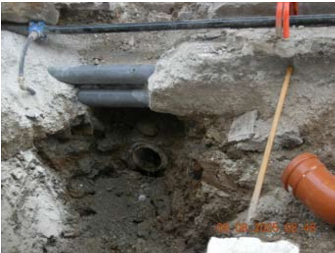
Excavación para otra acometida. Tramo de tubería que discurría envuelta en una pequeña cámara de ladrillo.
