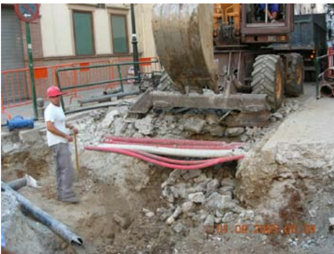
Comienzo de la excavación en la calle Molinos. Abajo se ve la tubería de saneamiento que se sustituyó.
