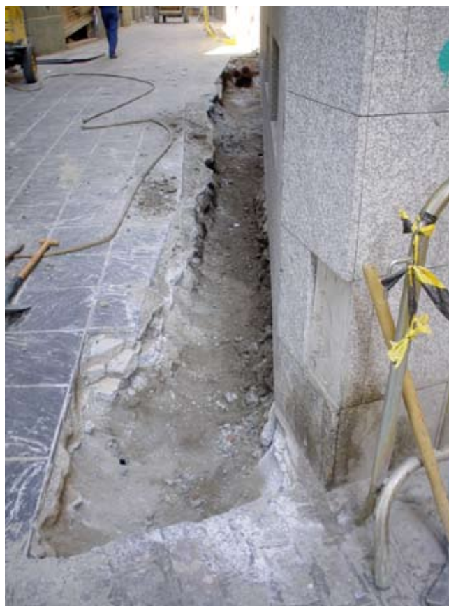
Lámina II. Vista general del recorrido de la zanja.
