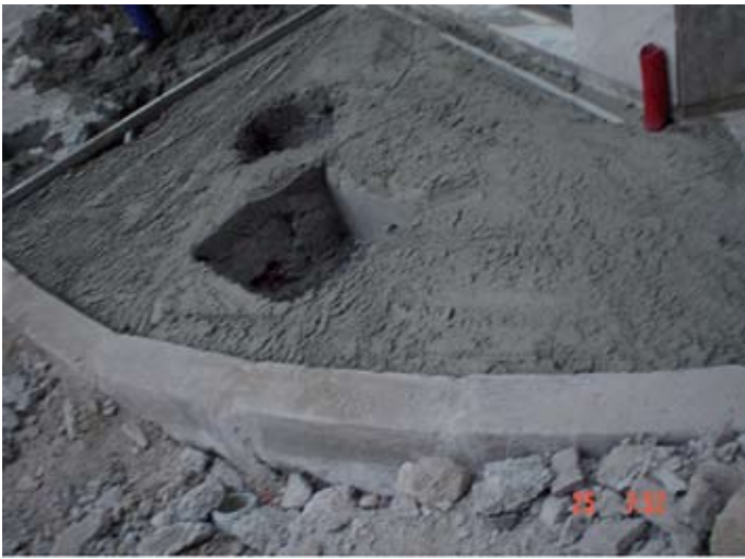
Lámina I. Detalle del rebaje en la calle Santi Espiritu
