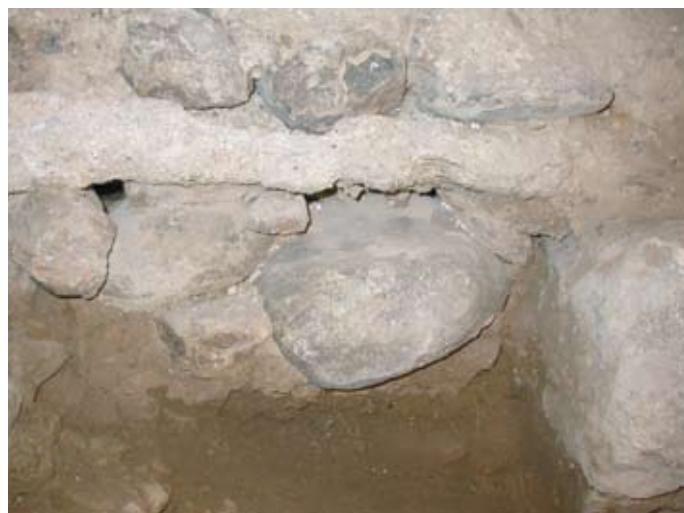
Lámina IV. Detalle de la técnica constructiva empleada en la torre: tapial y cantos.
