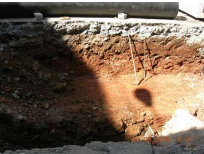
Excavación para acometida en la que apareció la estructura de ladrillo que podría ser de un horno.
