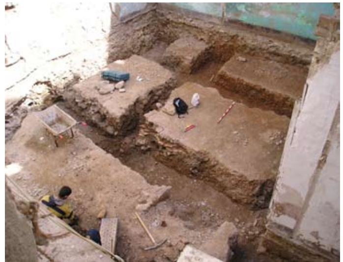
Lámina I. Planta del solar tras la apertura de las zanjas de cimentación.
