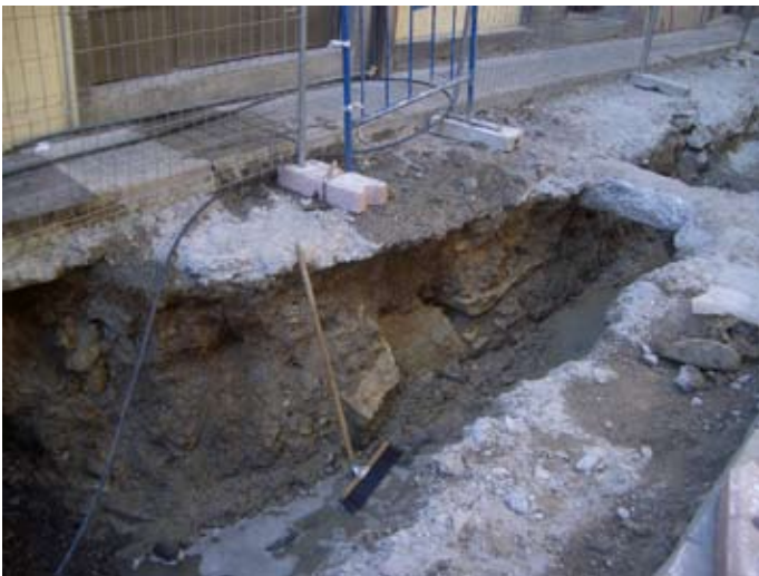
Perspectiva de la excavación. Perfil de la acera derecha. Se ve una bóveda de ladrillo que se aprovechó para instalar una acometida de las que se han sustituido. A la derecha hay un sillar
