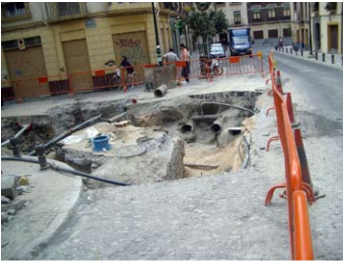
Cruce de la calle Molinos con la Plaza del Realejo. Se ven canalizaciones existentes de gran envergadura.
