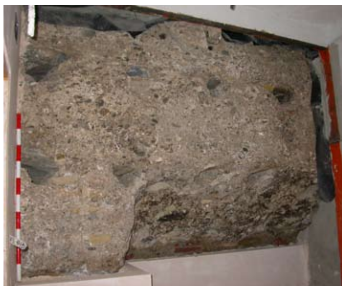
Lámina I. Vista General de la muralla en Planta Primera.
