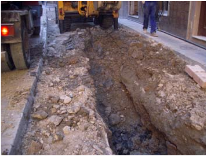
Perspectiva de la excavación. Perfil de la acera derecha. Se ve una bóveda de ladrillo que se aprovechó para instalar una acometida de las que se han sustituido. A la derecha hay un sillar
