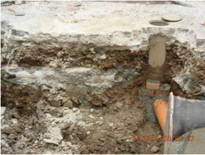
Perfil derecho. Se ven rellenos y otros servicios. Murete de ladrillo cortado por una acometida.
