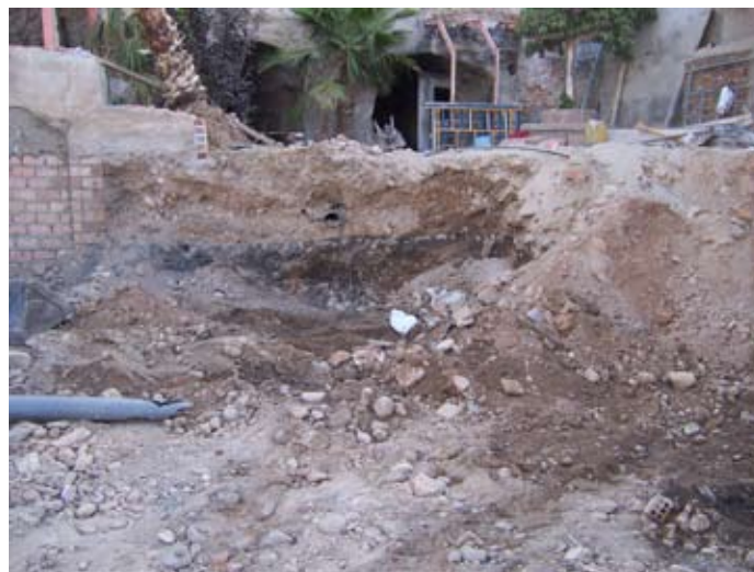
Lámina II. Detalle de rellenos al inicio de la excavación
