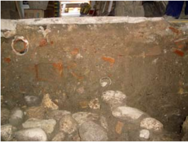
Detalle de los materiales sobre los que apoya el muro.
