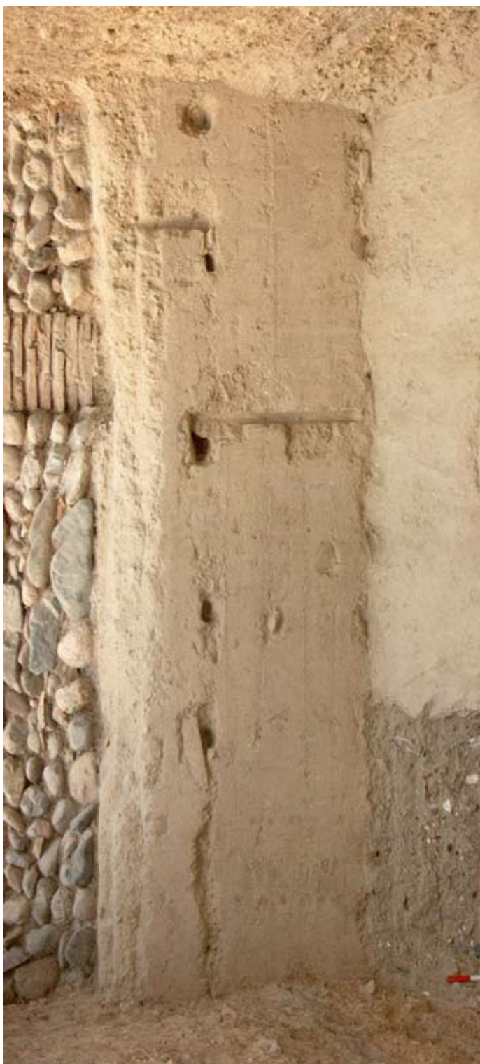
Lámina XVI. Alzado intramuros del muro de contención. Sondeo 02
