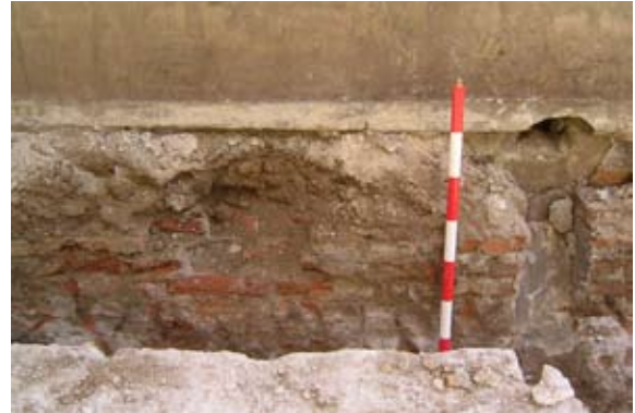
Lámina VI. Detalle zanja Almireceros
