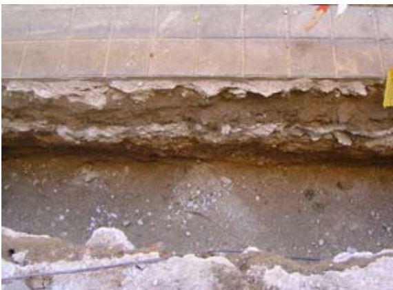
Lámina I. Detalle zanja calle San Jerónimo
