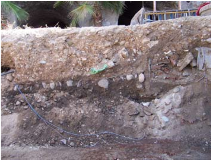
Lámina III. Detalle del perfil en el que se aprecia el empedrado
