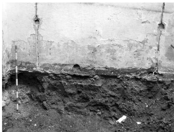
Lámina IV. Perfil 4, nivel de relleno con tierra y piedras.
