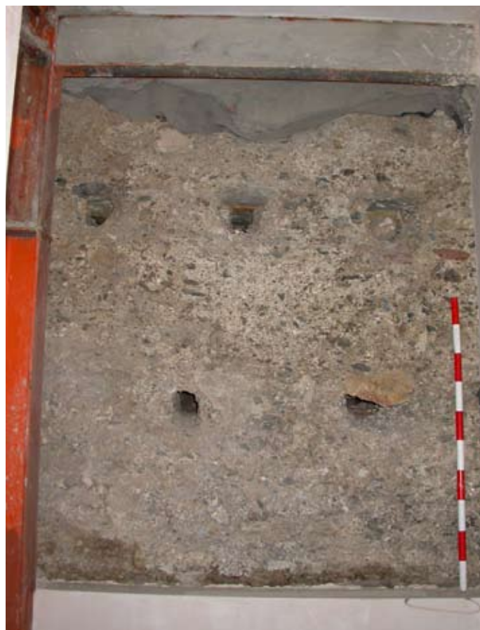
Lámina II. Vista General de la muralla en Planta Primera.
