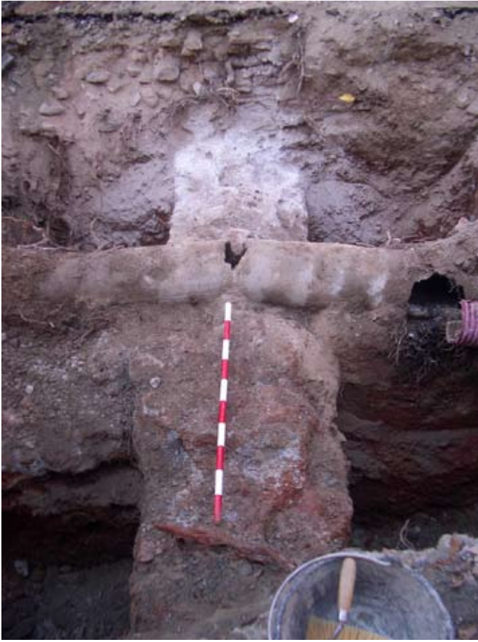
Lámina V. Lado sur del muro B tras su limpieza.
