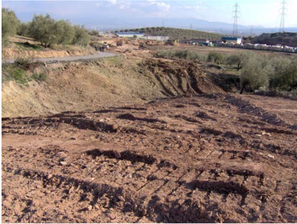
Lámina VII. Detalle del PK 300, en donde se aprecia el desnivel existente entre la zona ampliada y el camino tras la retirada de los olivos
