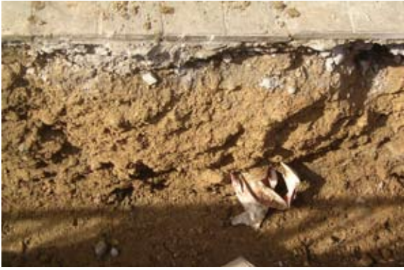
Lámina IV. Detalle zanja Gran Vía de Colón
