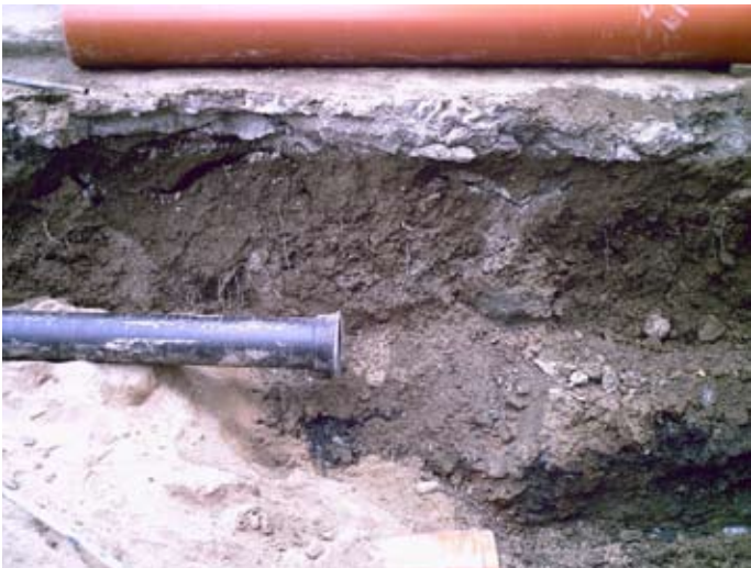
Lámina VII. Instalación nueva tubería.
