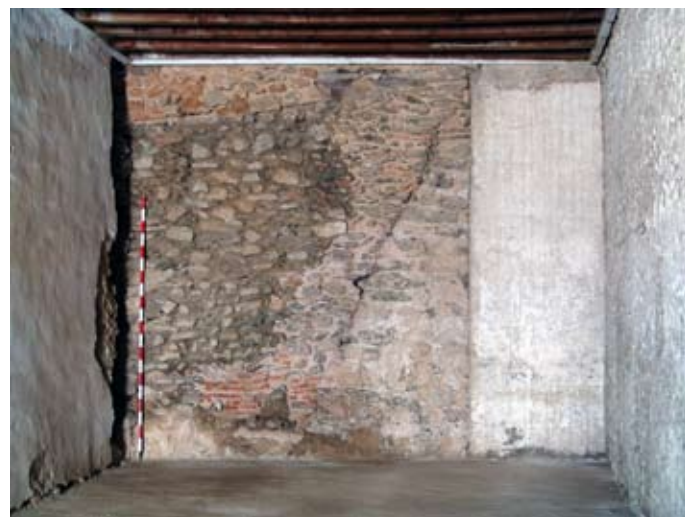
Lámina VI. Estudio de paramentos. Primer piso sobre H4 donde podemos ver las transformaciones acontecidas en el edificio: al fondo, el ángulo de la Torre, el contrafuerte de mampostería que se construyó en época árabe y que la envolvía por completo y los distintos muros pertenecientes a la casa solariega morisca.
