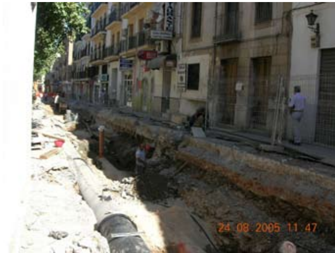
Perspectiva de la excavación en el último tramo de la obra. Ver la profundidad de las tuberías.
