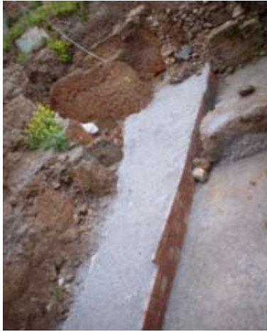
Lámina XI. Vista general de la cubrición.
