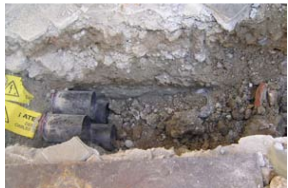
Lámina VII. Detalle zanja Valentín Barrecheguren
