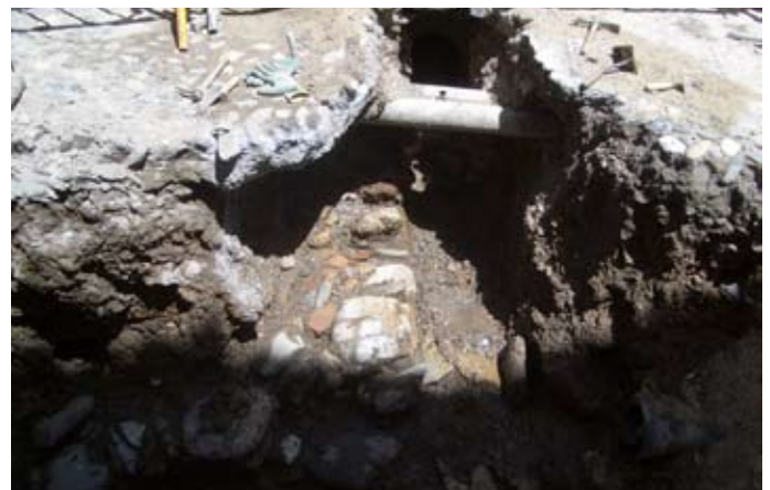
Perspectiva de la salida de la acometida de la casa. Pozo de piedra bajo la acometida.
