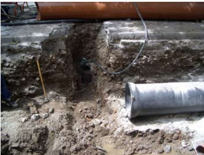
Excavación para otra acometida. Tramo de tubería que discurría envuelta en una pequeña cámara de ladrillo.
