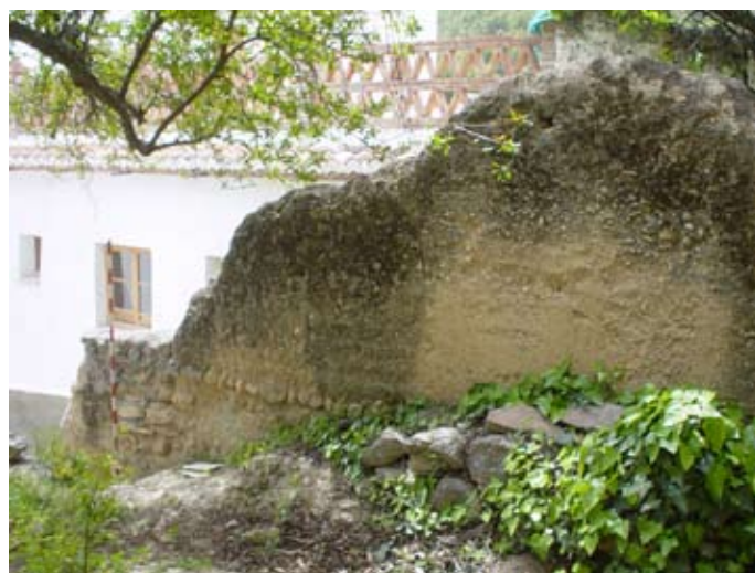
Lámina XI. Vista general de la UEM-001, muro de "cerca" en la finca colindante.
