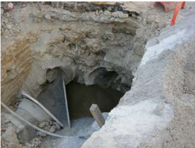
Cámara de gran tamaño de ladrillo y conexiones de distintas canalizaciones. Perspectiva de las obras en la Plaza del Realejo. Ver las grandes tuberías existentes.
