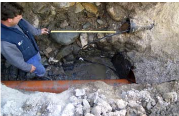
Perspectiva de parte del muro del perfil este.
