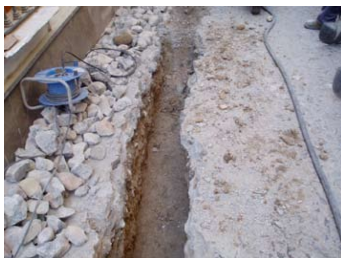
Lámina II.- Vista del recorrido de la zanja.
