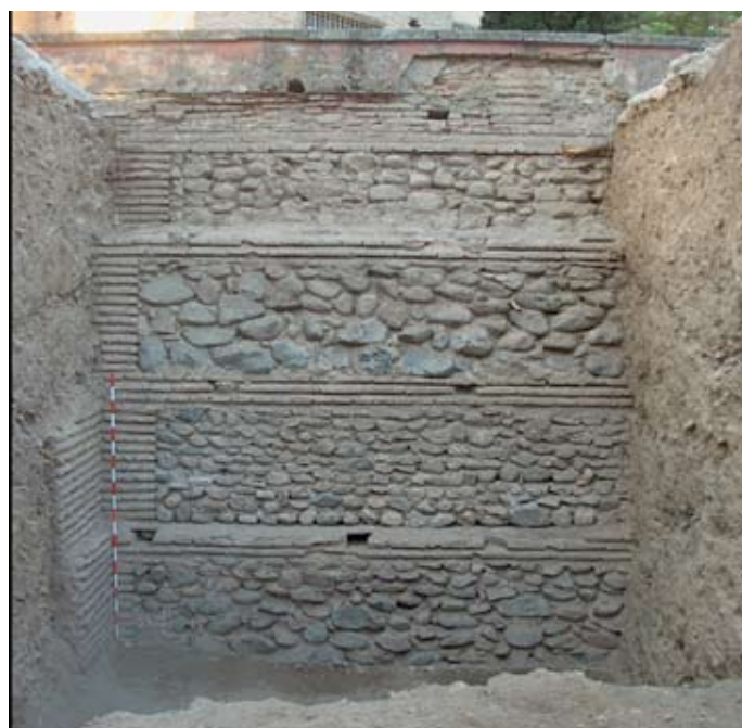
Lámina V. Vista general del muro de contención en el sondeo 10
