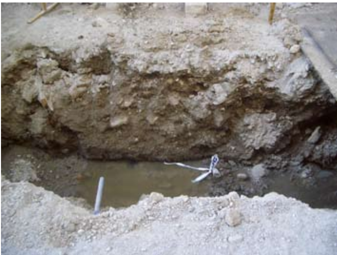
Perfil de la excavación. Se ve que todo son tierras de relleno.
