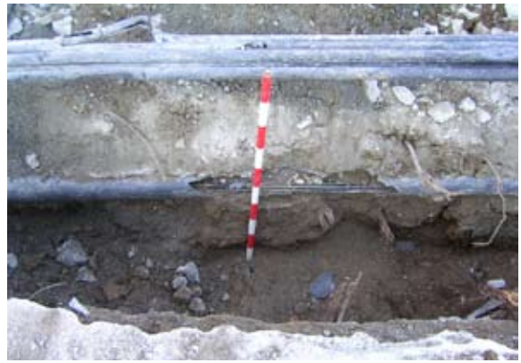
Lámina II. Detalle zanja Avenida de la Constitución
