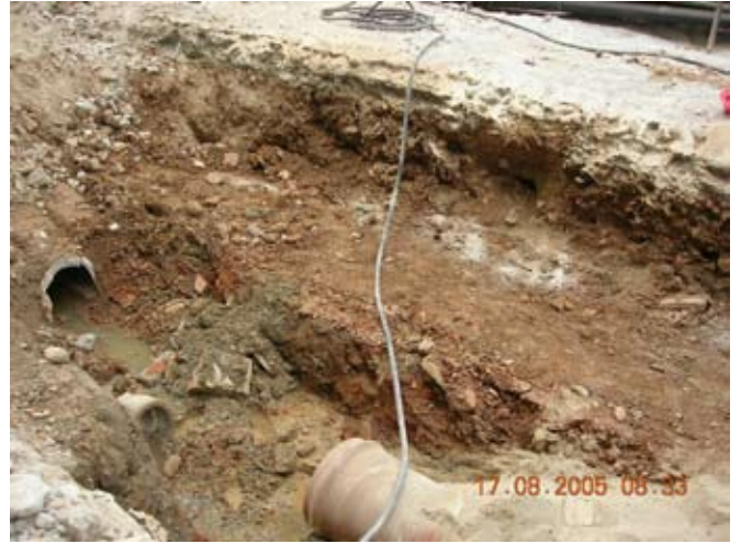
Excavación. Se ve la poca altura de las tuberías y las tierras rojas de relleno.
