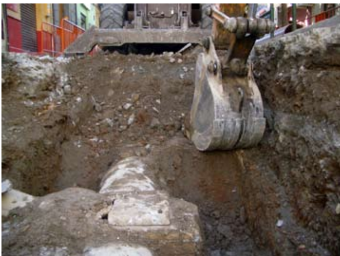
Excavación al principio de la calle Molinos. Se ven las tierras de relleno que cubrían las canalizaciones sustituidas.
