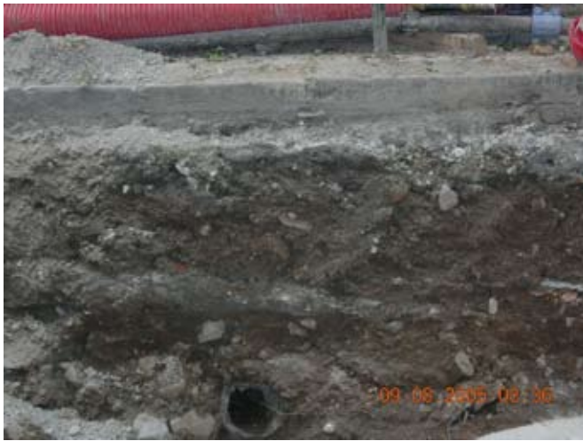
Detalle de uno de los perfiles. Excavación para una de las acometidas. Parece que hay un muro que debió romperse cuando se instaló el tubo que se ve al fondo.
