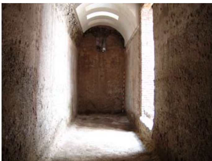
Lámina VII. Vista general del aljibe islámico integrado en la “Casa Grande”, una vez restaurado.
