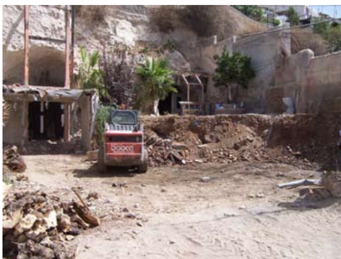
Lámina I. Detalle del proceso de excavación inicial
