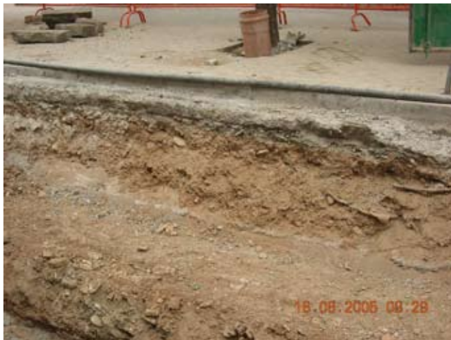
Perfil izquierdo a media altura de la calle. Se ve bajo e hormigón un murete de ladrillo de una conducción anterior. Instalación de las nuevas tuberías en el tramo intermedio de la calle.
