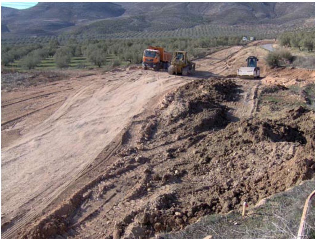
Lámina X. Trabajos de relleno y compactado del Tramo B (PK 200 a 400) para igualar la cota con el camino ya existente
