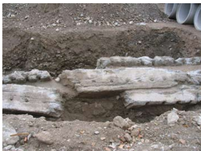
Vista general de Zona 2. Muro demolido.
