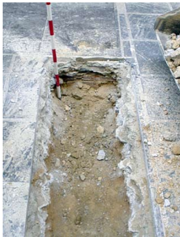
Lámina III. Vista de la conexión de la zanja con la arqueta.
