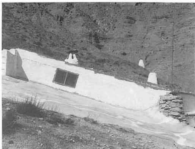
Gorafe. Granada. Refuerzo e impermeabilización de parte del terreno que constituye el techo de la casa cueva. En primer plano puede observarse la ejecución de un lucernario.
