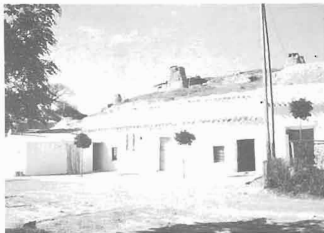
Cucharetas. Cortes de Baza. Granada. La fachada se remata mediante aleros de teja. En la placeta se levanta una pequeña construcción cubierta con uralita.
