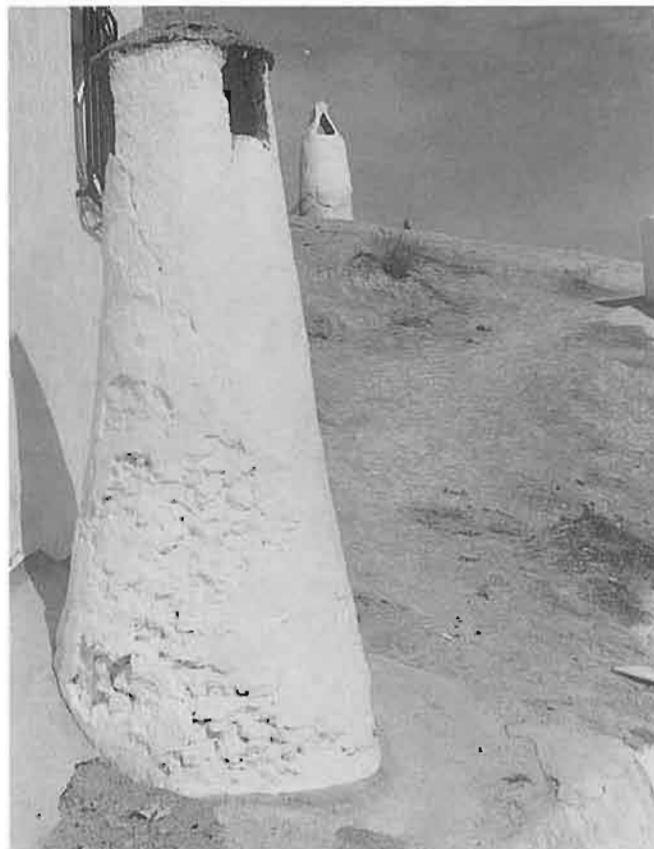
Solana Collado. Dehesas de Guadix. Granada. Detalle de chimenea.
