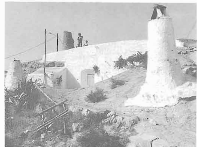
La Virgen. Gorafe. Granada. Pequeño anexo construido ante la fachada de la cueva. En primer plano, chimenea de la vivienda situada en el nivel inferior.
