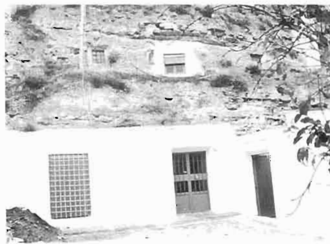
Galera. Granada. Aprovechando la considerable altura del talud vertical se excava en dos niveles.
