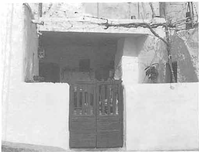
Salitre. Gádor. Almería. El espacio libre delantero se privatiza mediante una valla. Se ha cubierto en primer lugar con un porche de obra y después con una malla por la que trepa la parra.
