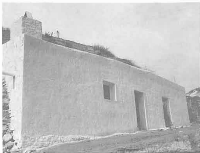
Cuevas San Marcos. Benamaurel. Granada. Para regularizar y reforzar el terreno se ha construido una fachada de bloques de hormigón.
