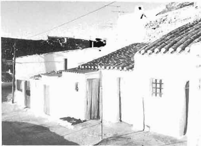
Barranco 1º. Cúllar Baza. Granada. El ancho de la calle ha permitido construir una crujía de edificación ante la cueva.
