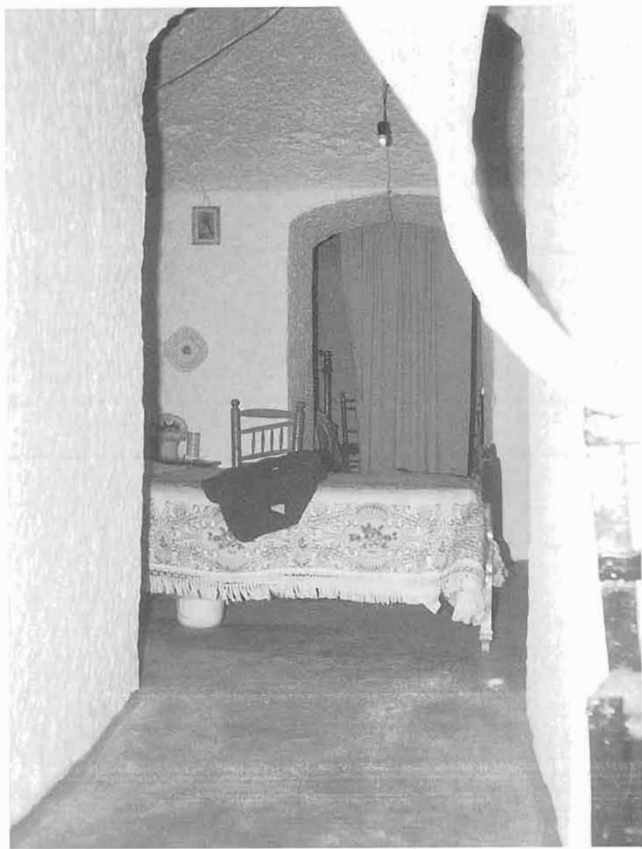
Lopera, Cortes y Graena, Granada. Los huecos de comunicación entre las diferentes piezas de la galería se alinean para facilitar el paso de la luz.
