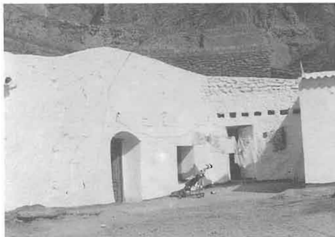
Las Eras. Gorafe. Granada. Al reforzar la fachada de la cueva con el muro de mampostería se han dejado unos mechinales, donde se apoyarán las viguetas de la construcción que se realice más adelante.
