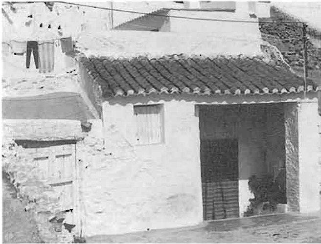
La Virgen. Gorafe. Granada. Delante del acceso a la excavación se ha construido un pequeño porche.
