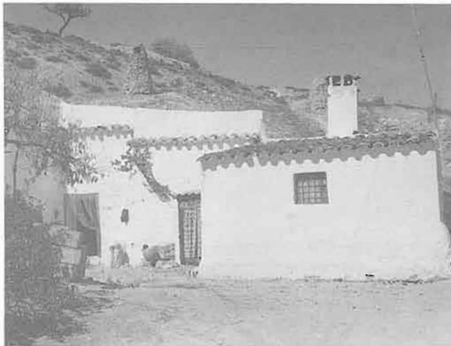
Los Garfios. Baza. Granada. Cueva casa cuya parte construida se ha realizado en la placeta.
