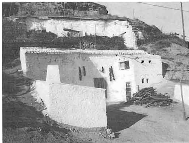
El Loro. Fonelas. Granada. Cortes verticales sucesivos permiten la realización de fachadas en diferentes niveles de la ladera.
