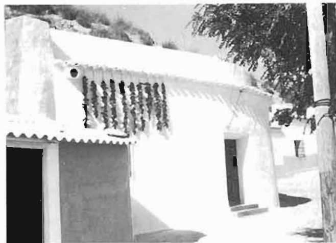
Cucharetas. Cortes de Baza. Granada. Ejemplo de fachada convexa, realizada a partir de la sección vertical del terreno.
