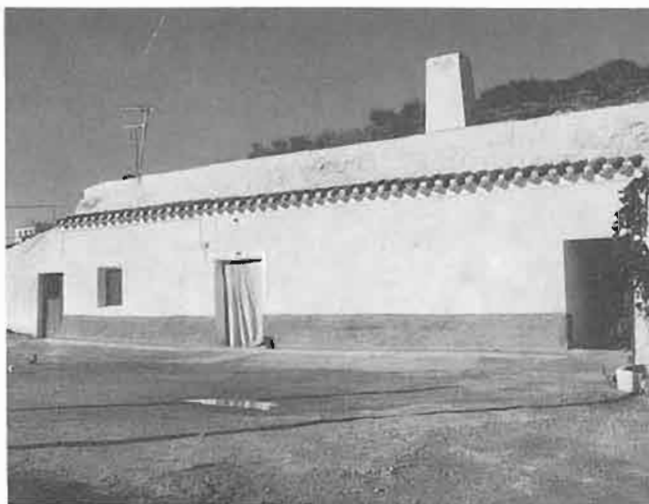
Barranco 3°. Cúllar Baza. Granada. La configuración del terreno posibilita la excavación de una cueva desarrollada paralelamente a fachada.
