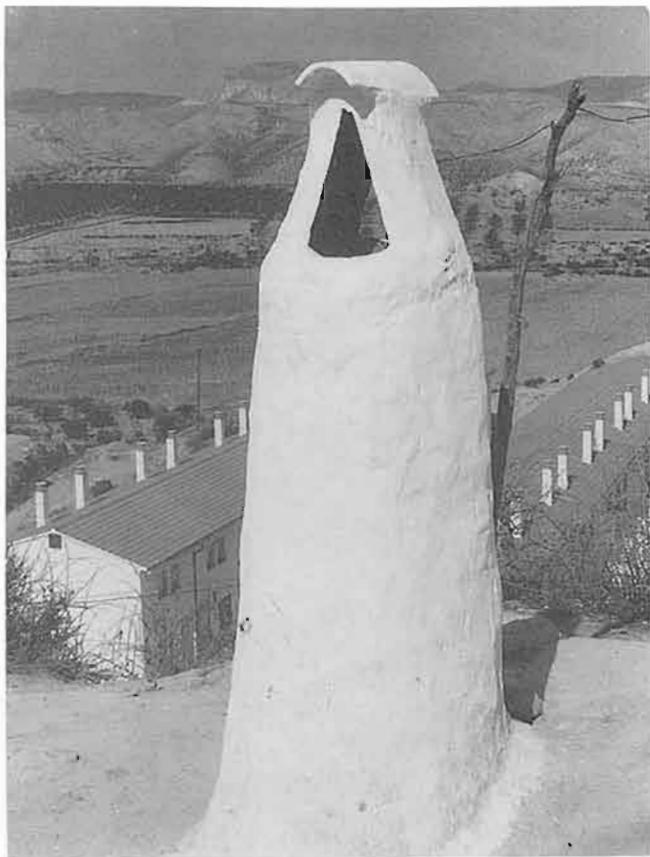
Umbria Collado. Dehesas de Guadix. Granada. Detalle de chimenea.
