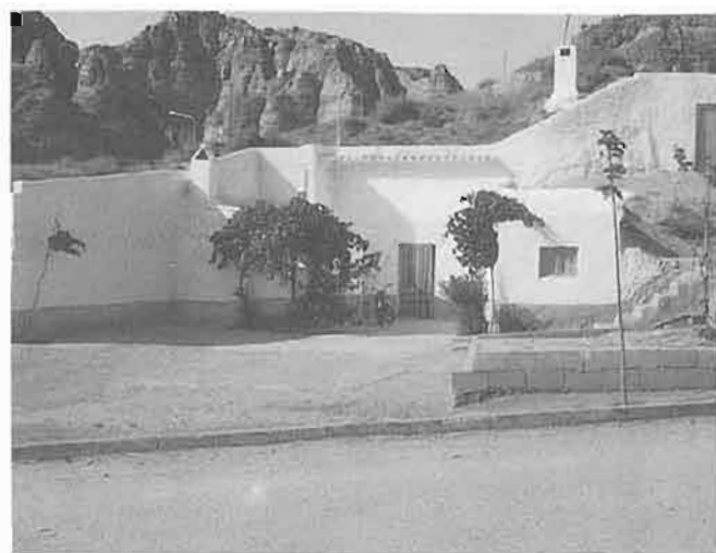
Barrio Alto. Purullena. Granada. Pequeño anexo que alberga el lavadero y baño situado en la placeta de acceso.
