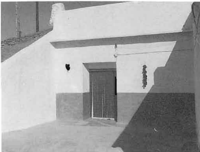
Los Pinares, Freila, Granada. Un corte vertical al terreno conforma la fachada y otros dos perpendiculares a él actúan como contrafuertes, controlando espacialmente la placeta anterior a la vivienda.
