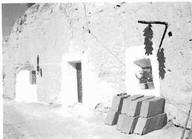
Cucharetas. Cortes de Baza. Granada. La fachada de la cueva es el mismo terreno. La única intervención ha sido el encalado del recezado de los huecos.
