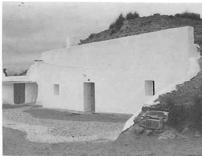
Cuevas de Luna, Benamaurel, Granada. Fachada construida a partir del corte vertical previo. La reducida altura del cúmulo permite mayor libertad para ubicar la chimenea.
