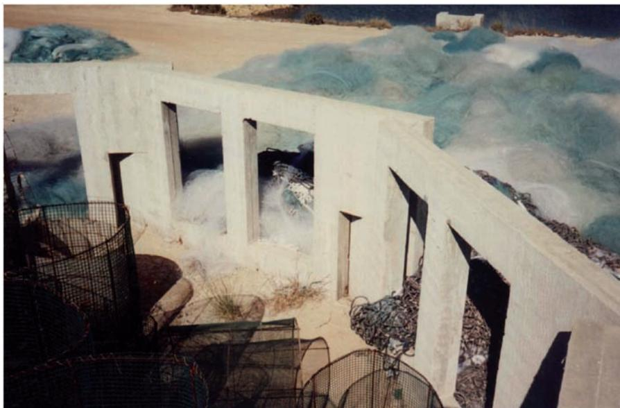
Forma en que se ensamblan los módulos tipo E para formar corrales.
