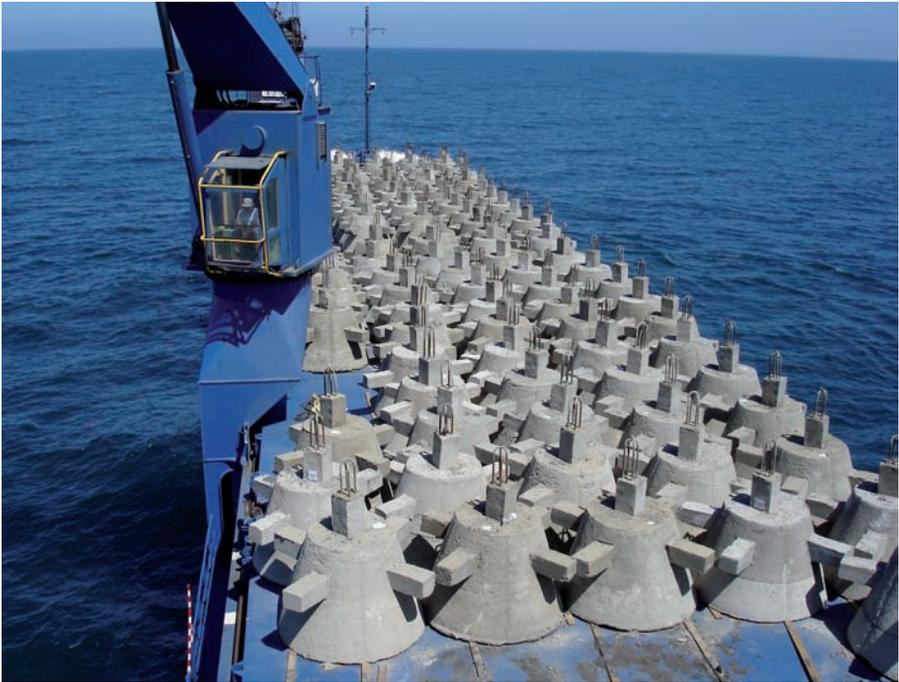
Módulos de protección de tipo troncocónico estibados en la cubierta del barco.
