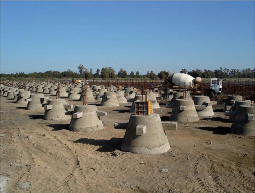
Construcción de módulos de protección troncocónicos en una zona habilitada en el puerto de Huelva.
