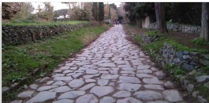
Vía Apia: calzada romana construida con losas de basalto
