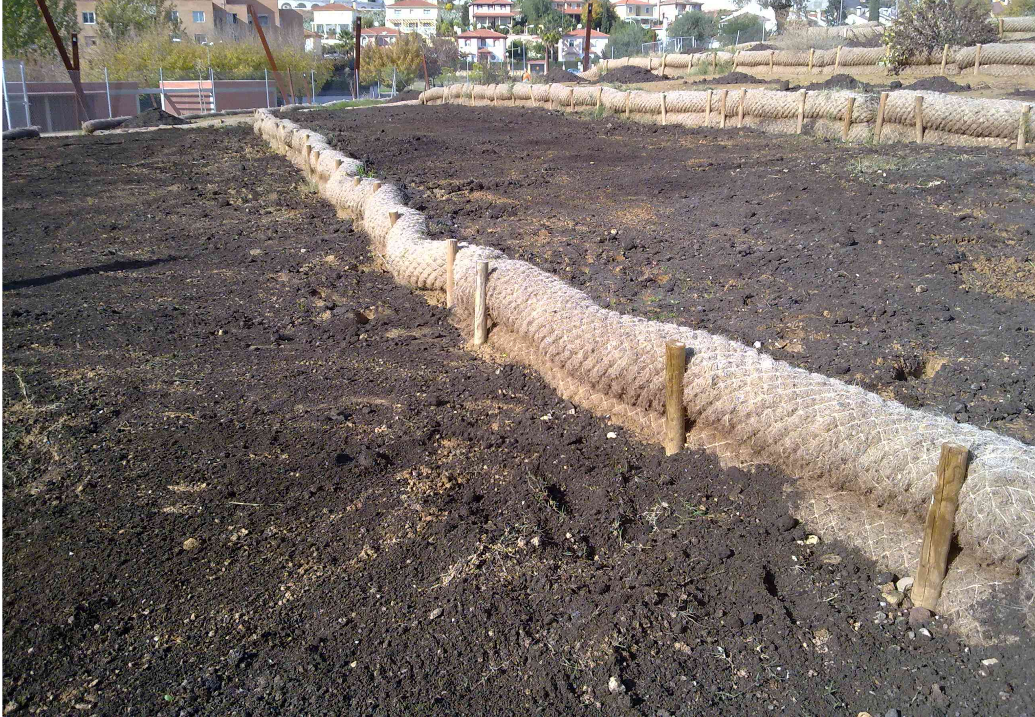
Aplicación de una capa de compost en las terrazas.
