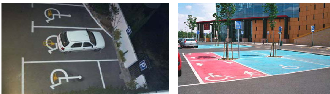
Gráfico 28.- Anclajes de acceso a plazas de aparcamiento para PMR y coloración del área de plazas reservadas para PMR.
