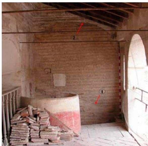
Fig. 19. Extremo oriental de la logia. Vestigios de dos fases constructivas sobre el paramento.
