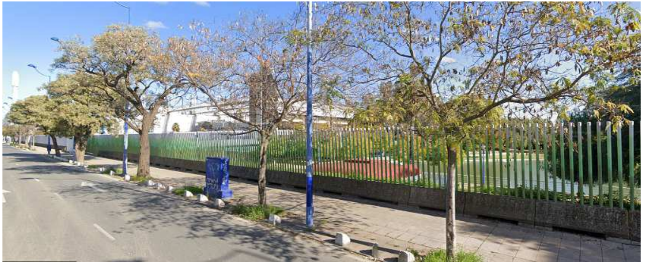
Vistas desde la calle Camino de los Descubrimientos , con las 3 pasarelas
