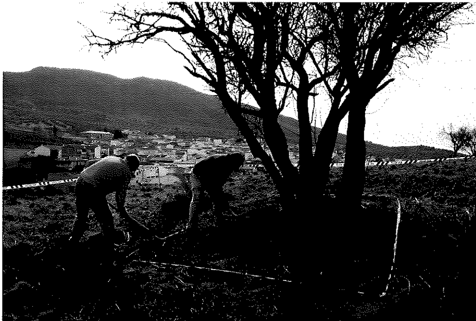
Marcación del sondeo y desbroce
