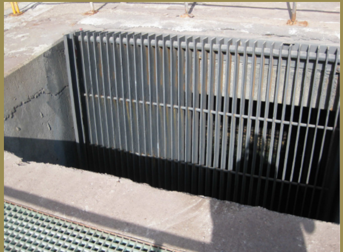
Piscina de decantación con sistema de filtrado donde finalmente encontraron al trabajador.
