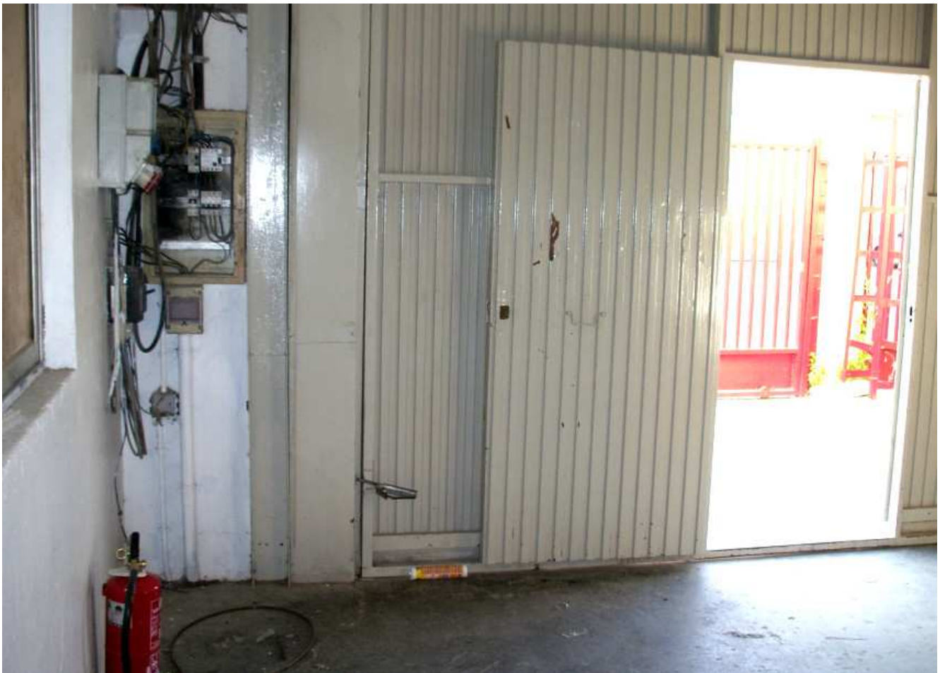
Imagen 6. Lugar donde cayó el trabajador accidentado, junto al cuadro principal del centro de trabajo
