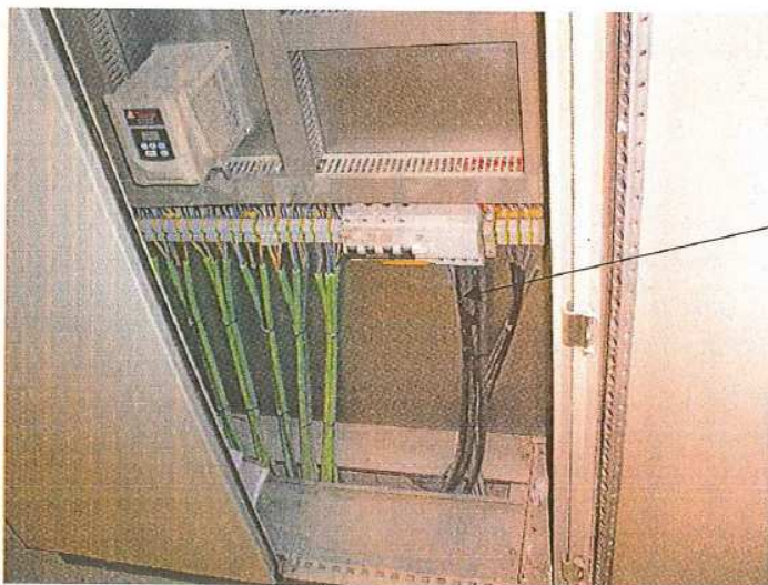
Imagen 2. Acometida de los cables unipolares al cuadro del túnel de pintura
