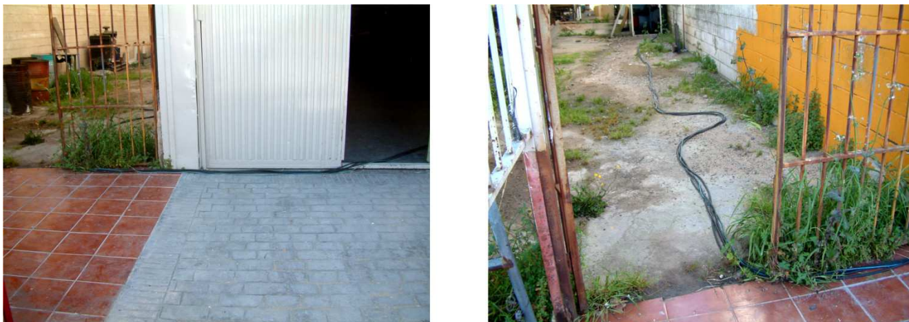
Imagen 3. Los cables unipolares iban por el suelo del exterior de la nave de pintura, hasta conectar con una manguera tripolar enchufada al cuadro principal de la instalación
