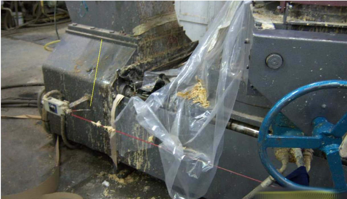
Imagen 6. Cable de parada de emergencia de la máquina espiraladora, dispuesto a la altura de la pierna.
