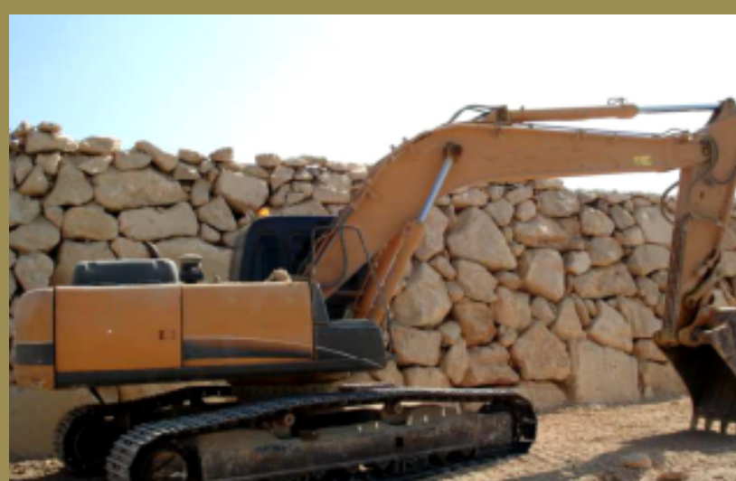
Excavadora hidráulica de orugas utilizada por el operario autónomo en la ejecución del muro de escollera.
