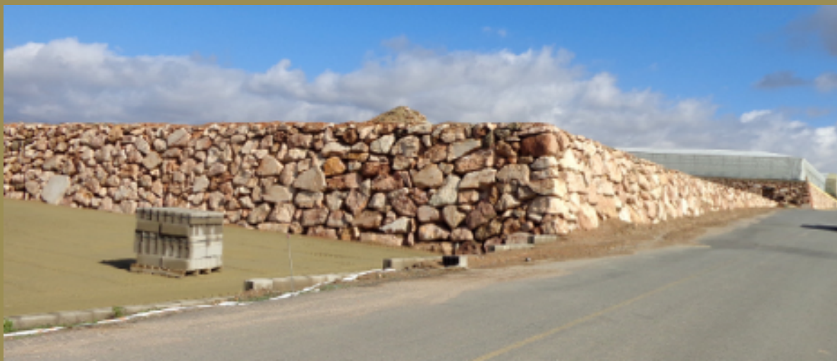
Arriba, imagen del estado inicial de la parcela antes del inicio de los trabajos (fuente Google Maps). Abajo, muro de escollera ya construido
