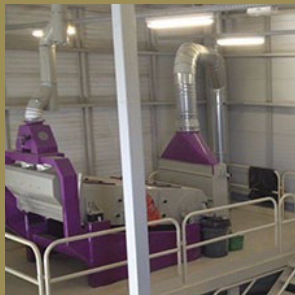
Maquinaria que tenía que ser desarmada y trasladada a otra instalación
