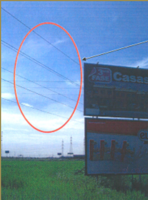
Línea eléctrica debajo de la que se situó el camión .
