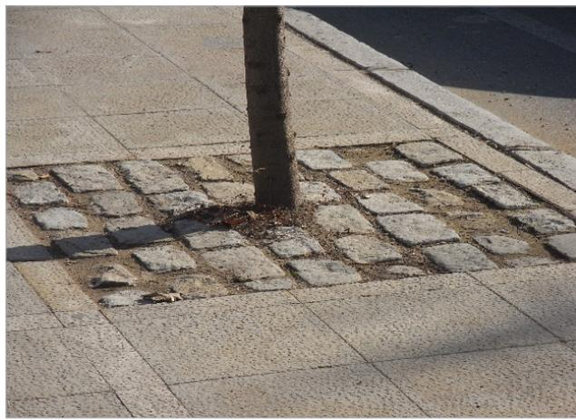
Imagen 1.5\_38. Alcorque cubierto con adoquines.
