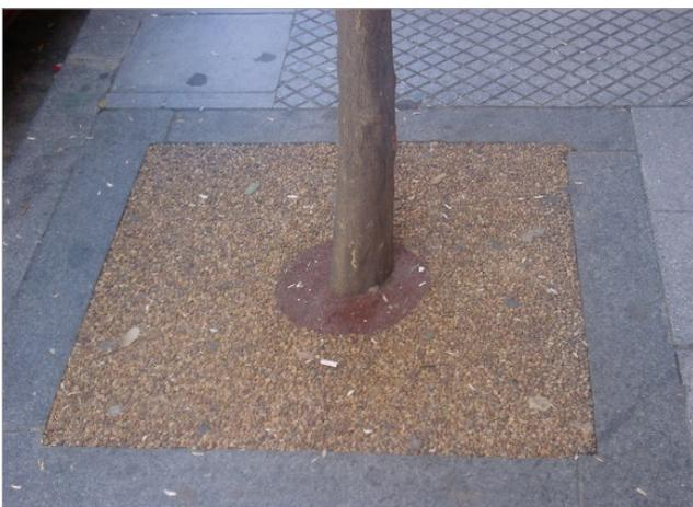
Imagen 1.5\_37. Alcorque cubierto con resinas sintéticas.
