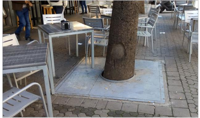
Imagen 1.5\_42. Alcorque cubierto por una chapa metálica, estancia para el agua y el aire.
