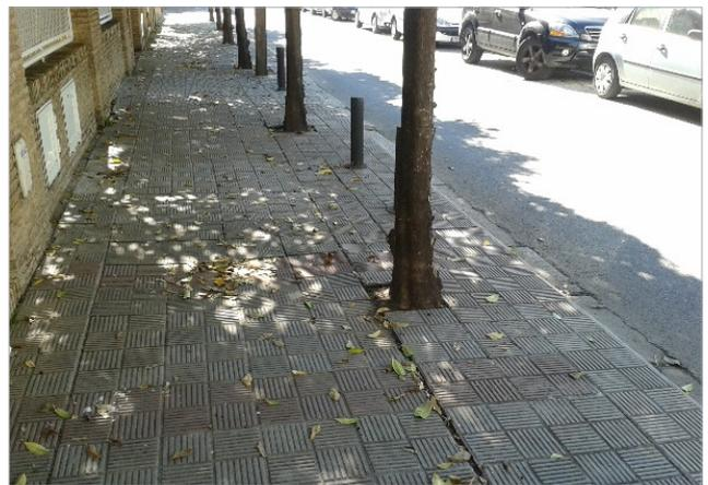
Imagen 1.5\_32. Alcorque cubierto con losetas de pavimentación. La necesidad de agua y de oxígeno del sustrato, se ven limitadas por no tener una superficie libre de intercambio.
