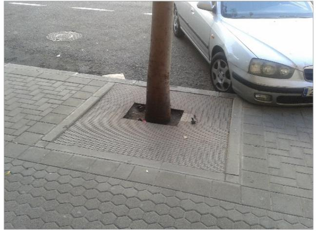
Imagen 1.5\_30. Alcorque cubierto con una estructura metálica.
