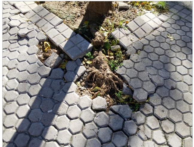
Imagen 1.5\_46. Pavimento levantado por raíces al no poder penetrar en un suelo compactado o duro.
