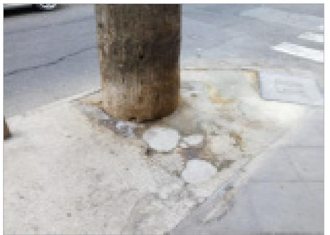
Imagen 1.5\_16. Destrozo del acerado debido a la existencia de un alcorque sin el volumen de sustrato (suelo) adecuado para una especie arbórea de gran porte.
