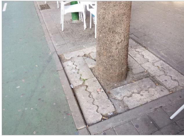
Imagen 1.5\_36. Alcorque cubierto con losetas de hormigón.
