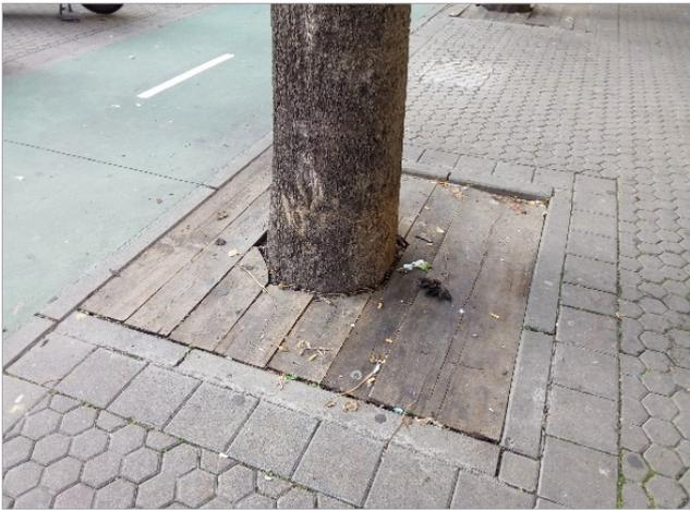
Imagen 1.5\_35. Alcorque cubierto con planchas de madera.
