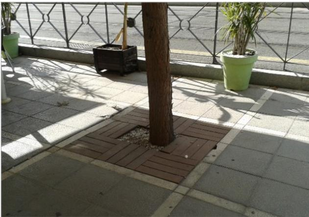
Imagen 1.5\_31. Alcorque cubierto con losetas de pavimentación.
