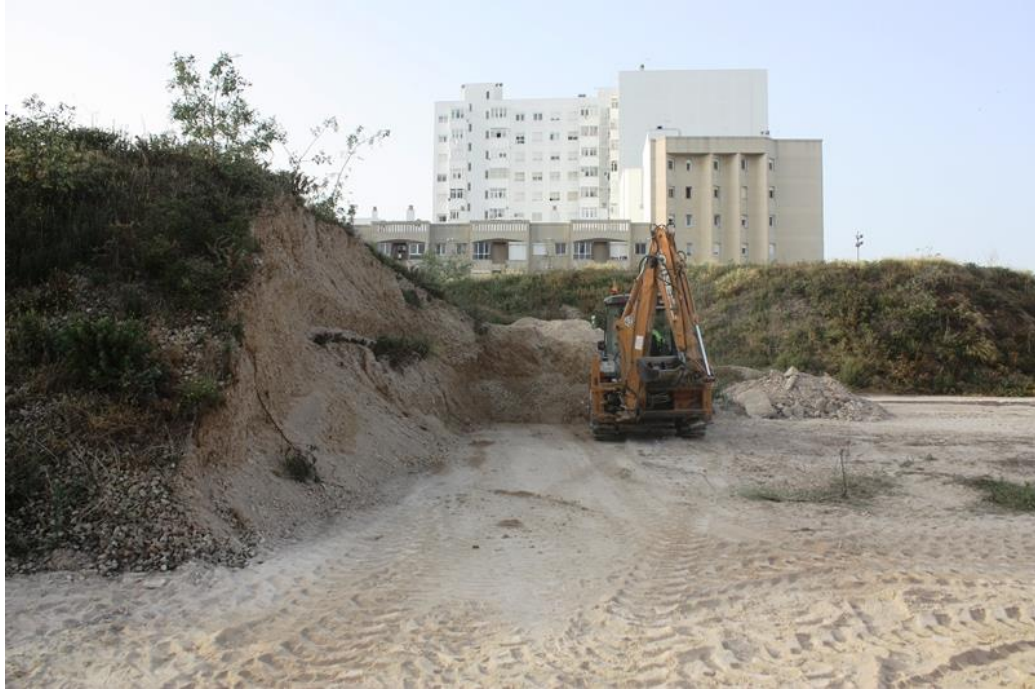
Retirada de escombros.
