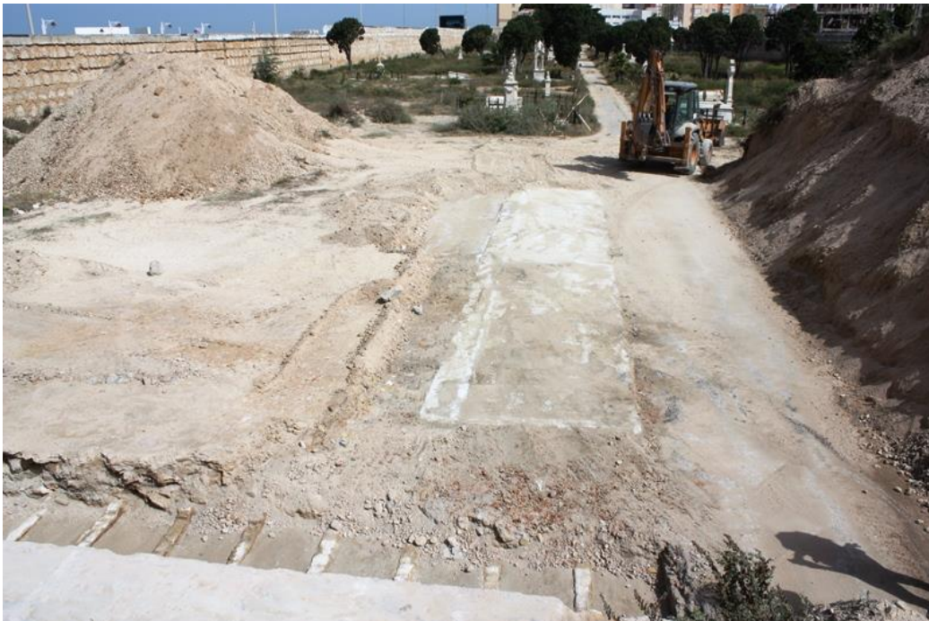
Calle central (a la derecha) y la cimentación de un bloque de nichos bajo el que se encuentran las tumbas (a la izquierda).
