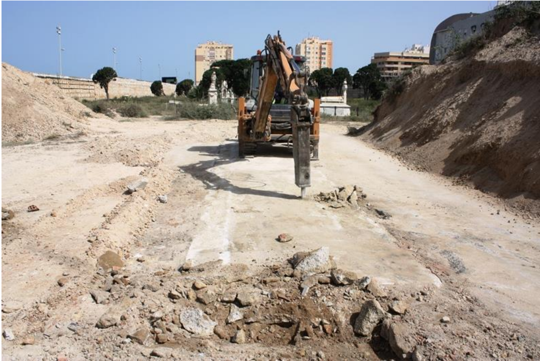
Retirada de la cimentación en el Patio 6.
