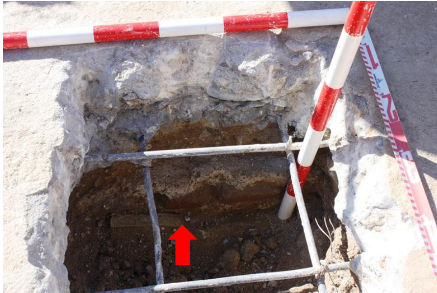
Sondeo de comprobación del potencial de la solera de hormigón. La flecha señala la citara de ladrillos
