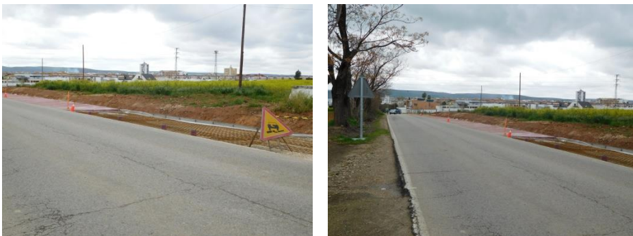
Ilustración 44: Carril bici en ejecución en Andújar.
