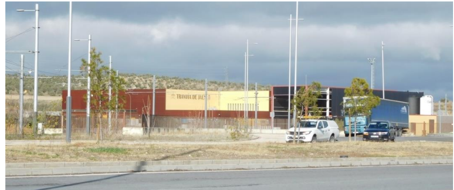
Ilustración 68: Cocheras y talleres del Tranvía de Jaén.
