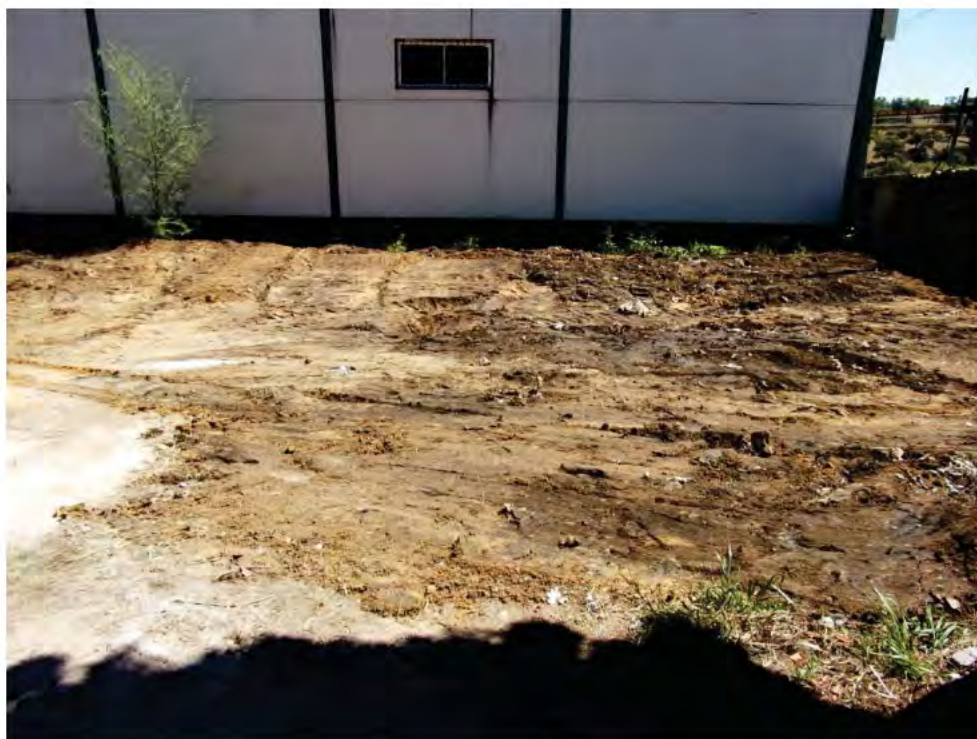
Zona restaurada con los sondeos cubiertos
