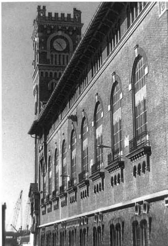
El conjunto presenta un basamento, de piedra, sobre el que se levantan muros de ladrillo visto con grandes aberturas necesarias por el uso y una torre almenada que indica el acceso principal; detrás de esta fachada, el interior. Está formado por naves cubiertas con estructura metálica.
