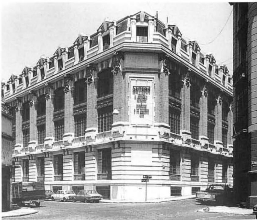
Completando el conjunto de la antigua Casa de la Moneda, en 1889 se adquieren estos terrenos para el edificio que habría de contener las máquinas impresoras. Se trata de una construcción representativa de la tradición funcional inglesa, de estructura metálica con entresijos de vigas de hierro y bovedillas, y posee un interesante frente de ladrillo a la vista con detalles de excelente factura.
