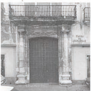
Palacio del Pumarejo 156 * Siglo XVIII B 2 Plaza del Pumarejo Convertido en 1883 en casa de vecinos
