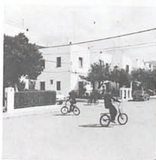
Conjunto de viviendas 265 "Vistaflorida". Hacia 1938 B 2 Plaza de Vistaflorida Luis de Sala y María Este arquitecto construye en 1938-1939 las nuevas manzanas del viejo Los Remedios, delimitadas por las calles Niebla, Arcos, Turia y Miño
