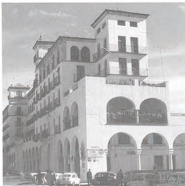
14 Mercado de Entradores del Arenal. 1947. Un ejemplo más donde residencia y edificio singular yuxtaponen sus estructuras en esa relación de convivencia tan ligada al proceso de construcción de la ciudad.
