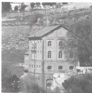
Estación elevadora de agua Adufe. 1885. 13A
