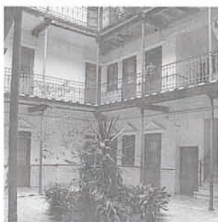
Edificio de viviendas. 226 1918-1920 B 6 Calle Progreso, 27, esquina a calle Felipe II Manuel Martínez Mas
