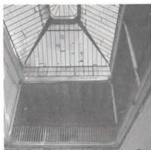
Edificio de oficinas y talleres 166 1897 B 3 Calle Castellar, 48, 50 y 52 Francisco Ortiz
