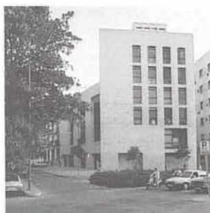
Sede del Colegio Oficial de 314 Arquitectos. 1976–1979 B 3 Plaza del Cristo de Burgos, 35 Enrique Perea Caveda Gabriel Ruiz Cabrero
