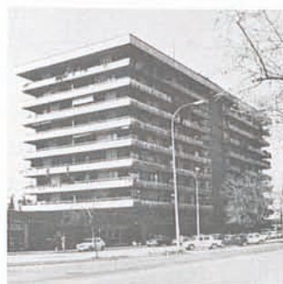
Edificio de apartamentos "Huerta del Rey". 1967-1968 296 A 4 Avda. Eduardo Dato, 22 Manuel Trillo de Leyva
