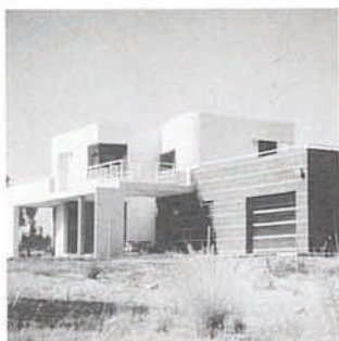
Casa Nazario. 1981-1982. 41A Urbanización Torrequinto, parcela 50. Alcalá de Guadaíra. María Dolores Gil Pérez. Manuel Gavilán Camacho. Manuel Ramos Guerra. Autores igualmente de la casa construida sobre la parcela 62 de la misma urbanización.
