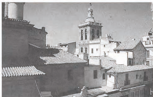
4 Iglesia del Salvador. Al borde de la indeterminación de los límites —donde empiezan las casas y donde el monumento— casas y tiendas se integran con imprecisión en el edificio religioso. La torre barroca construida sobre la base del viejo alminar va a proponer la alineación de la calle Córdoba.
