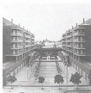
Edificio de viviendas, 316 mercado y locales B 2 comerciales. 1980–1982 Ronda de Capuchinos, 4 y 6 Antonio Cabrera P. de León Ángel Díaz Domínguez Antonio González Córdón Francisco Torres Martínez
