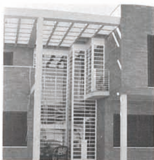
Casa Valencia. 1976–1979 312 Calle Conde de Osborne Barriada Santa Clara Antonio González Córdón
