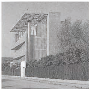
Central Internacional y Telepuerto de Telefónica. 1989-1991 Carretera de Pineda, s/n Guillermo Vázquez Consuegra
