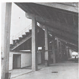
Estadio Olímpico y Parque Público de Chapina. 1965-68 293 Jaime López de Asiain Colaboradores: Ángel Díaz Domínguez Pablo Fábrega Roca Pierre Vanier Demolido
