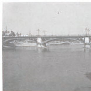
Puente de Triana. 1847-1852 177 ** Rio Guadalquivir C 4 Bernadet y Steinacher Terminado por C. Corroza Proyecto reconstrucción. 1975 Juan Batanero, ing. Dirección de obras: 1976-77 Manuel Ríos Pérez, ing.
