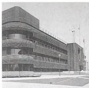
Edificio World Trade Center Expo'92. 1989-1992 Camino de Triana Antonio Vázquez de Castro
