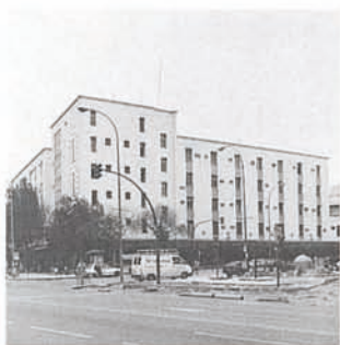
Ambulatorio Esperanza Macarena. 1964-1966 292 B 3 Calle María Auxiliadora, 4 Fernando García Mercadal Autor igualmente de los ambulatorios de calle Doctor Fleming y calle Marqués de Paradas
