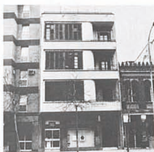
Edificio de viviendas. 1934 Calle Recaredo, 32 Joaquín Díaz Langa L. Gómez Estern
