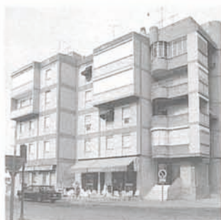
Edificio de viviendas. 1967-1970 295 A 6 Calle Felipe II, 31, 33 y 35 Luis Marín de Terán Rafael Arévalo Camacho Autores del edificio de viviendas (1967-1968) de calle Gorrion, 12 y 16
