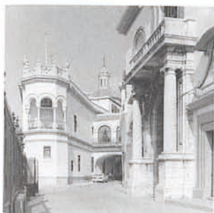
Sede de la Real Maestranza. 1925-1928 Paseo de Cristóbal Colón Aníbal González Capilla. Terminada en 1956 Aurelio Gómez Millán R. Medina Benjumea F. Barquín y Barón
