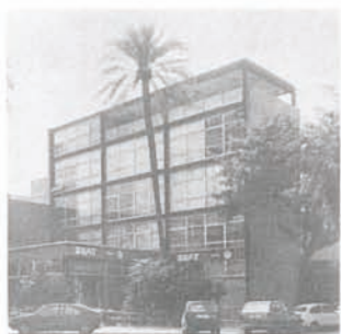
Talleres SEAT. 1957 Calle Gaspar Alonso, 1 esquina a calle Porvenir César Ortiz Echagüe Rafael Echaide Itarte Ramón Monserrat Ballesté Demolido
