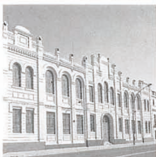
Fábrica de tejidos. 1908-1909 204 Calle Torneo, 26 Aníbal González C 2 Adición de la quinta nave con fachada a Francisco Pizarro en 1919-1920 Reforma interior en 1992
