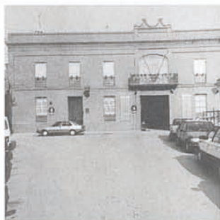
Antiguo Cuartel de la Policía Armada. Siglo XIX 175 Calle Crédito, 3 C 2 Restauración y Adaptación para Sala de Teatro y multiuso 1987-1989 Ignacio de la Peña Muñoz
