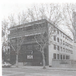
Edificio para Sede del 315 Colegio de Aparejadores y B 6 Arquitectos Técnicos y viviendas. 1979–1981–82 Avenida de la Borbolla, 41 Luis Marín de Terán Aurelio del Pozo Serrano Colaborador: Enrique Haro Ruiz
