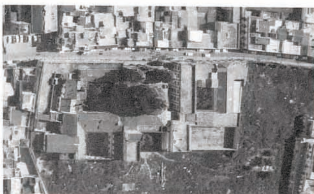
2 Iglesia de San Luis y su entorno próximo. Es uno de los más grandiosos edificios de la arquitectura barroca española. Se instala en la trama urbana sin utilizar ningún mecanismo que avise sobre su singularidad —si acaso ese pequeño retranqueo de la alineación de la calle—.
