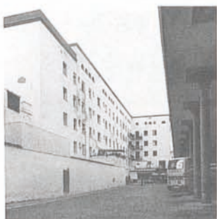
Estación de Autobuses 266 ** 1938-1944 B 5 Prado de San Sebastián Rodrigo Medina Benjumea Reparación y reformas en 1992
