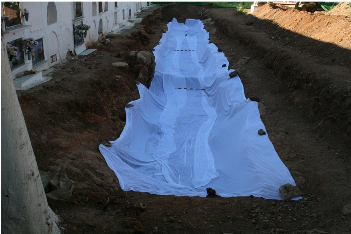
Lámina. Detalle de colocación de la malla geotextil.
