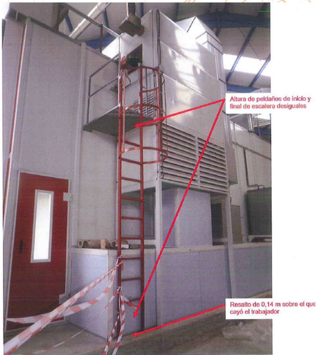
Imagen 1. Imagen real de la escalera completa
