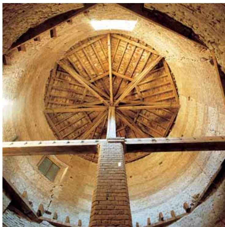
A la izquierda, la zona de cuadras, en cuya esquina se sitúa un pajar de planta circular. A la derecha, una estructura de machón central y pendolón sostiene la cubierta de madera del pajar.
