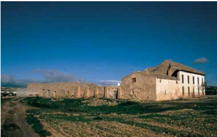
A la izquierda, vista desde el suroeste donde se aprecia la presencia de pies de amigo empleados como contrafuertes. A la derecha, fachada principal, en la que el señorío presenta una composición ordenada de huecos.
