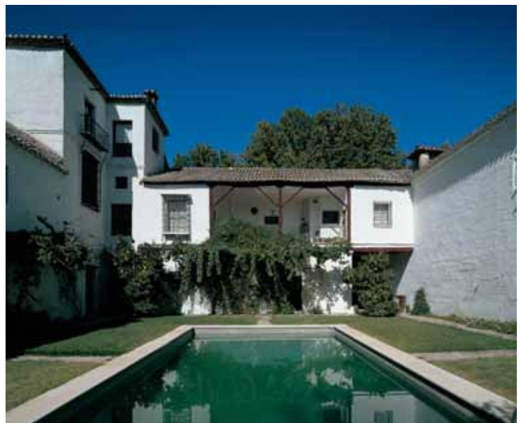
Interior del patio hacia la zona de vivienda, donde aparece una solana resuelta con estructura de pies derechos y jabalcones de madera.
