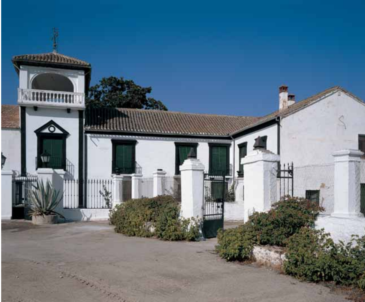
Casería Santa Ana, Pinos Puente.
