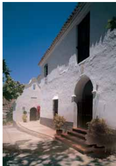
La fachada principal de acceso al señorío, con la capilla dispuesta perpendicularmente a la misma.
