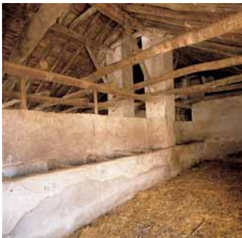
Estructura de rollizos de carpintería sobre machones en una de las naves.
