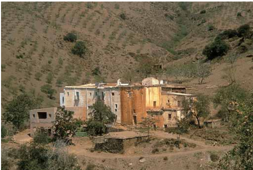
En la imagen exterior de Bordavarela puede apreciarse la disposición de volúmenes coronados por cubiertas planas propia de la arquitectura agraria de las Alpujarras granadinas. Arriba, detalle de la torre de contrapeso del lagar.
