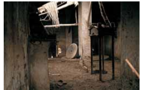
Interior de la nave del molino, con la prensa hidráulica en primer plano y el empiedro al fondo.
