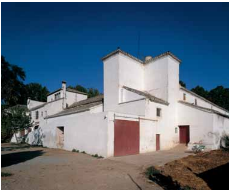
Exterior donde se sitúan las dos torres de contrapeso de los antiguos molinos de viga.
