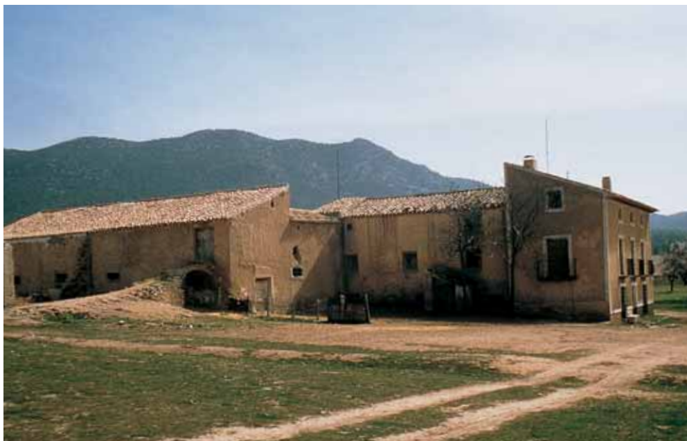
Vista exterior, con la pieza de la vivienda principal a la derecha, caracterizada por la composición racional de huecos de su fachada y la planta de cámara de remate de la misma.
