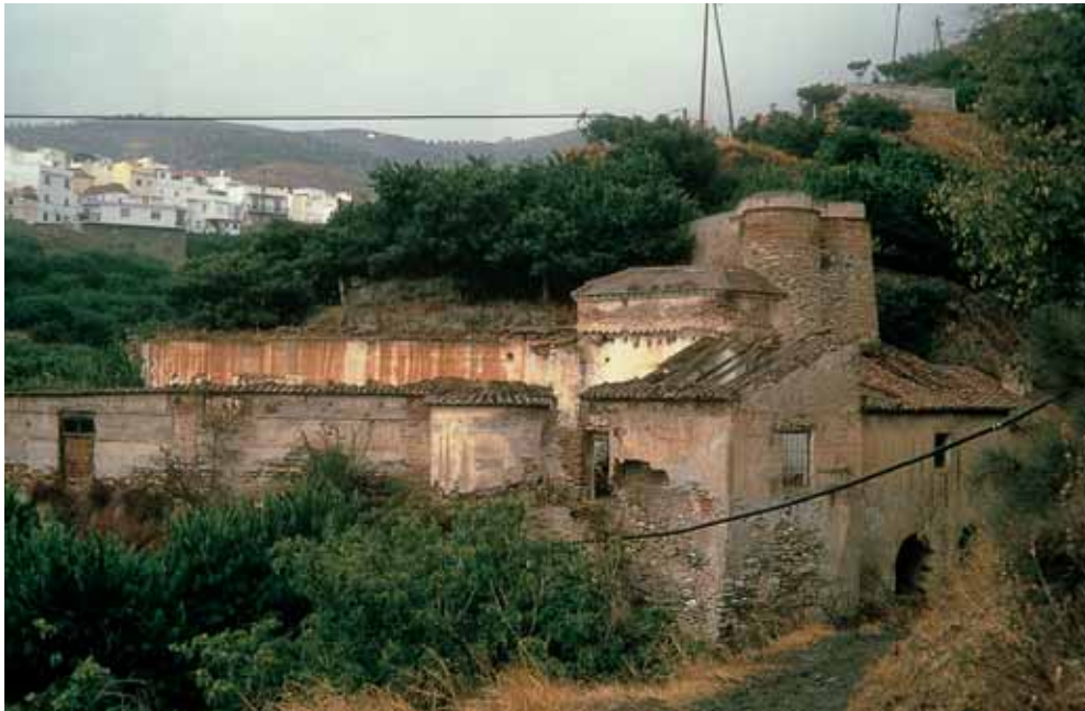
Vista exterior desde el sur con los cubos cilíndricos para el salto de agua de la aceña destacando sobre el volumen edificado de dos plantas.
