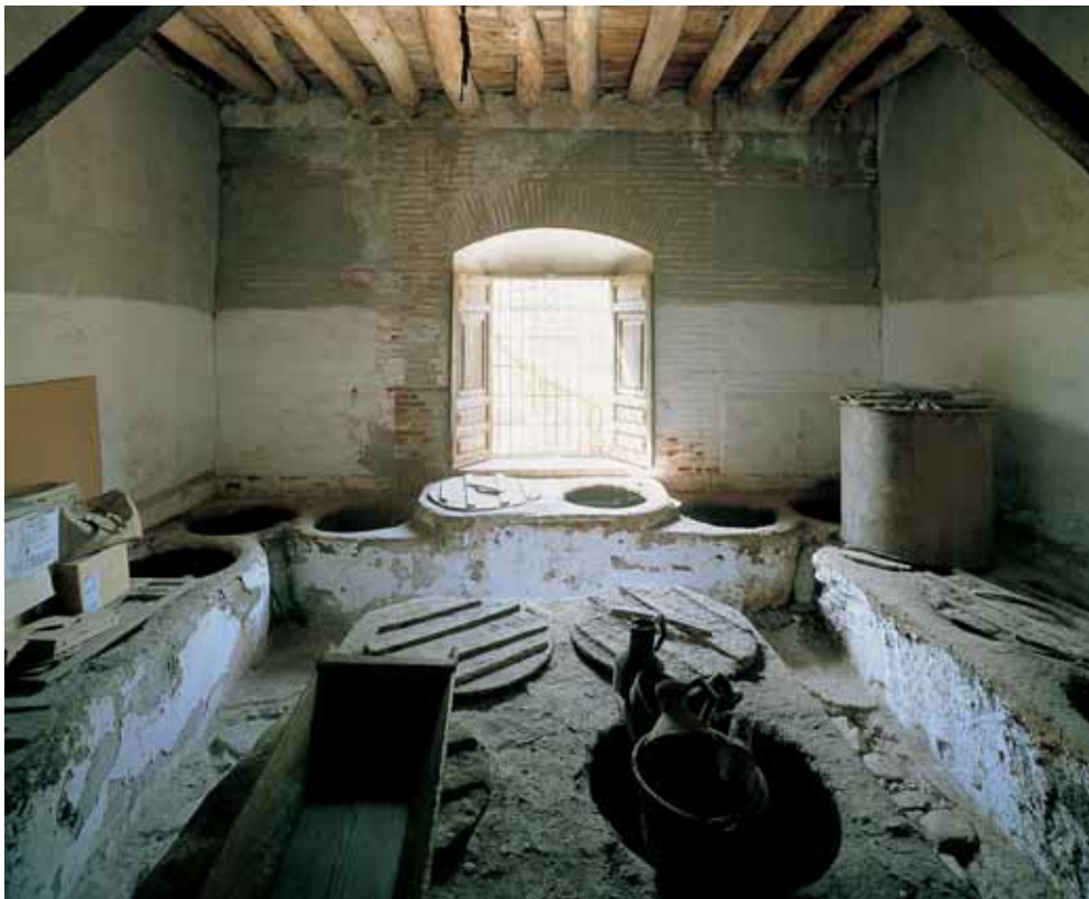
La bodega de aceite se situaba en el centro de la edificación principal, entre las dos naves de prensado. Bajo estas líneas, las naves de las prensas de viga. En la nave occidental aún se mantienen la antigua caldera del molino (en primer plano), y el empiedro (al fondo). En la imagen inferior, la inconclusa zona de vivienda.
