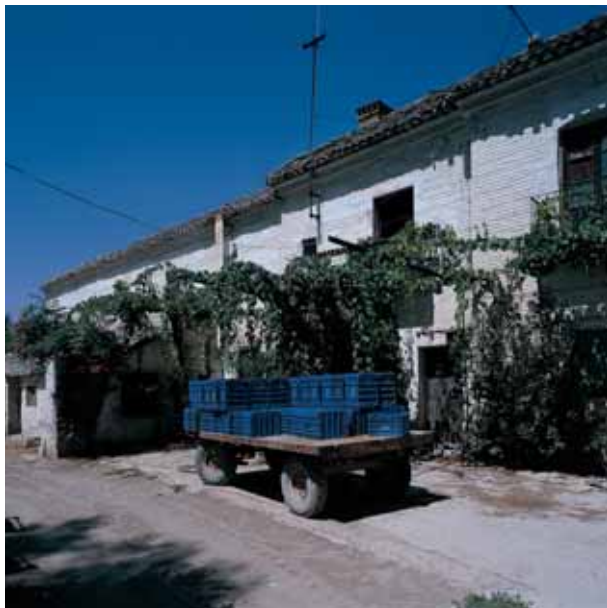
A la izquierda, El Alitaje, Pinos Puente, fachada de la vivienda de trabajadores. A la derecha, Cortijo de Gabarres, Loja, vivienda del casero.
