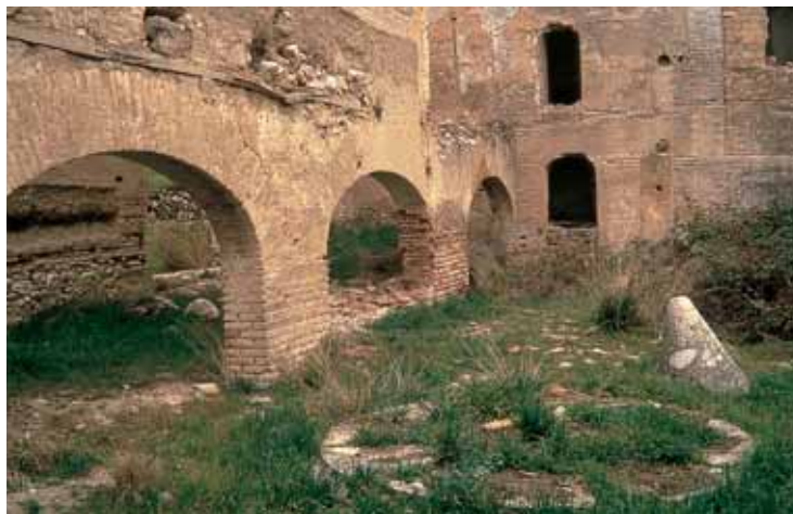
Restos del molino de aceite de prensa de viga.
