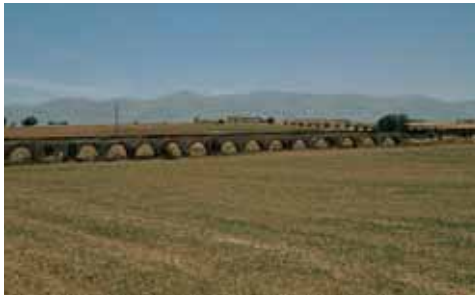
Acueducto a su paso por la finca del Cortijo de Buenavista.
