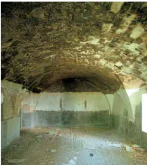
Horno de pan con bóveda de cañón ubicado junto a la aceña de la hacienda.
