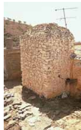
En la imagen exterior de Bordavarela puede apreciarse la disposición de volúmenes coronados por cubiertas planas propia de la arquitectura agraria de las Alpujarras granadinas. Arriba, detalle de la torre de contrapeso del lagar.
