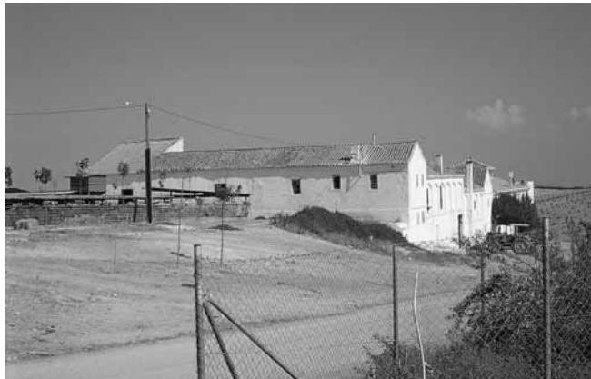
Cortijo de Santa Catalina, Chimeneas.
