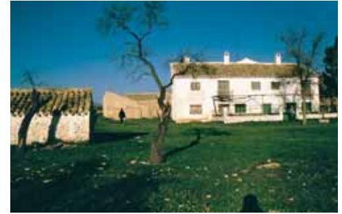
Cuerpo secundario añadido a la estructura originaria en U del cortijo, cuyo patio se cerraba con una tapia.
