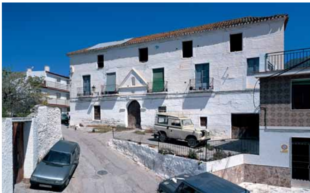
Fachada principal en fábrica mudéjar enjalbegada presidida por una portada apilastrada con tímpano.
