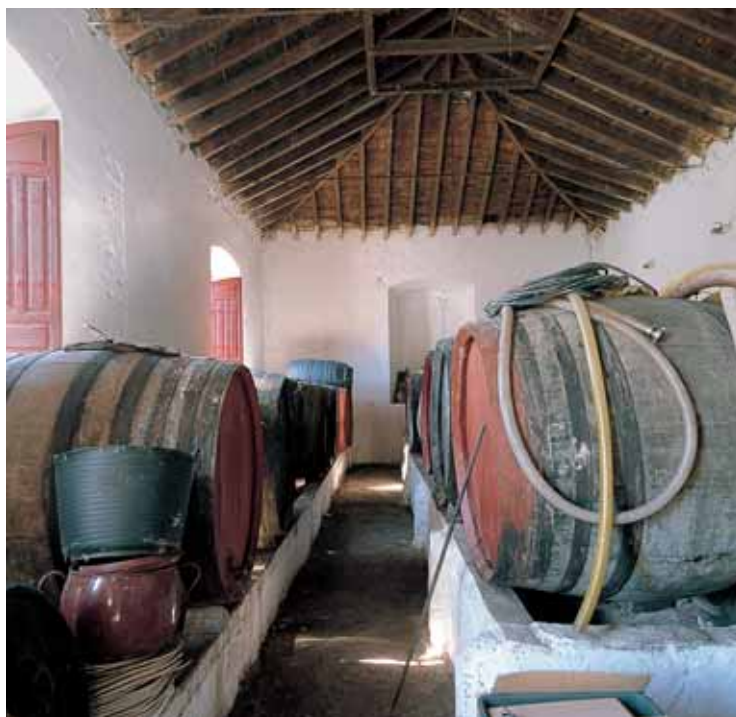
A la izquierda, bodega de crianza, con cubierta de madera de vigas escuadradas. A la derecha, planta de remate resuelta con machones centrales de ladrillo y cubierta a dos aguas de madera de rollizos.
