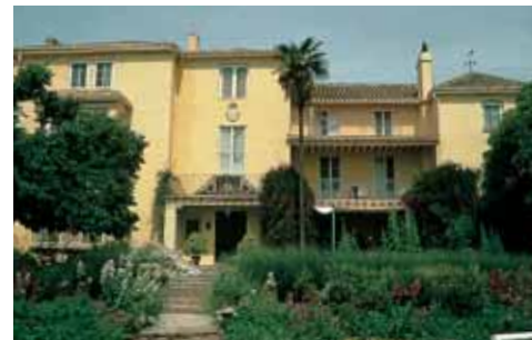
El señorío o vivienda principal de la explotación, en la Cortijada de la Torre, concebido como una quinta de recreo, que vincula las dependencias de habitación a una zona de jardines.
