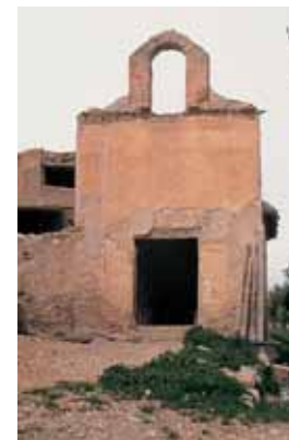
Fachada de la capilla, coronada por una sencilla espadaña.
