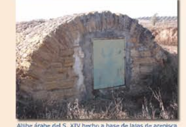
Aljibe árabe del S. XIV hecho a base de lajas de arenisca del terreno
