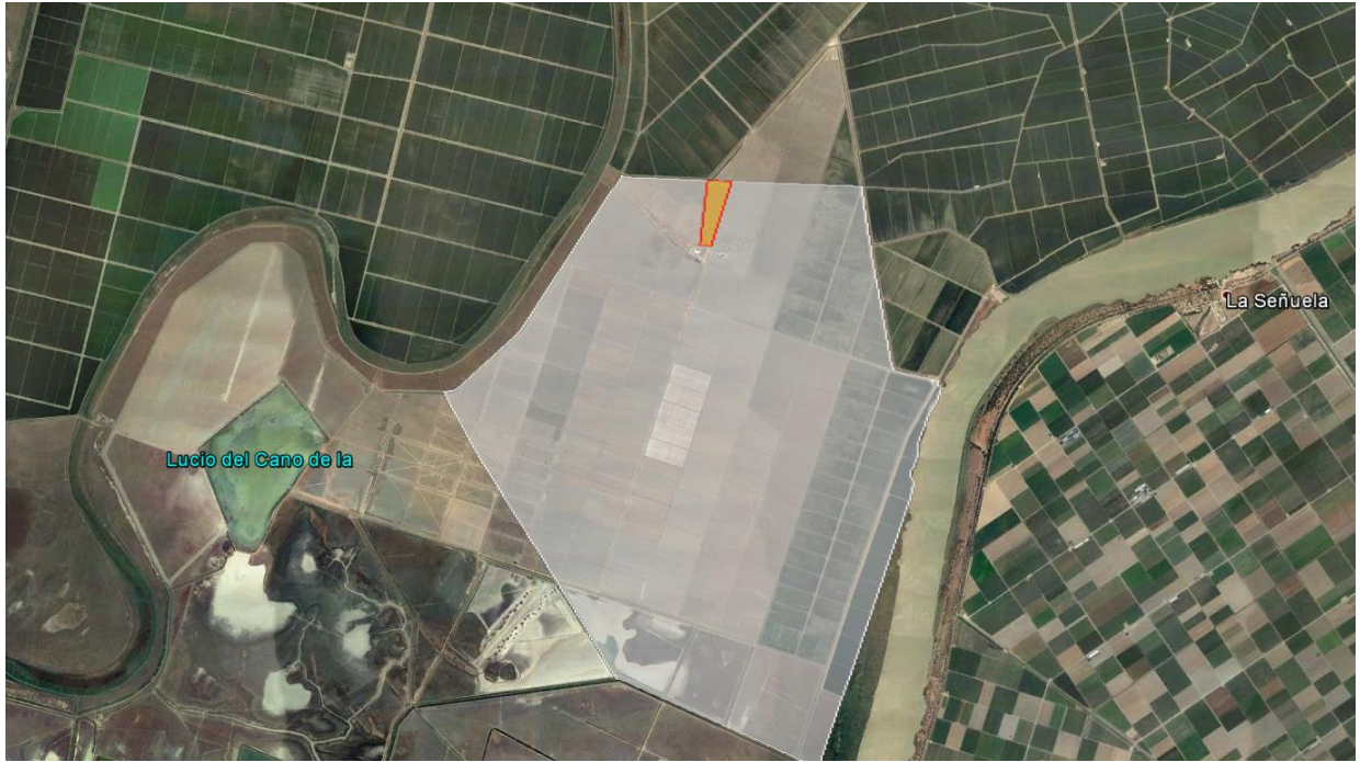
Figura 2: Parcela y punto de conexión a red interior MT de Veta la Palma.
