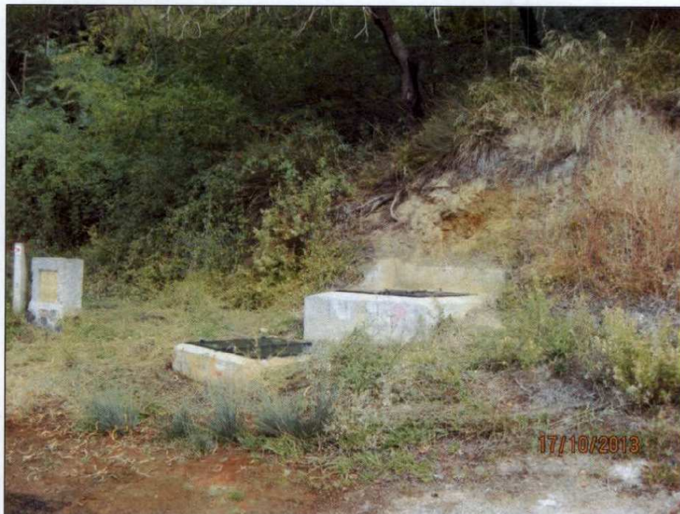
Fotografía nº 5.- Manantial FERRUGINOSO-2: Arquetas de protección y captación.
