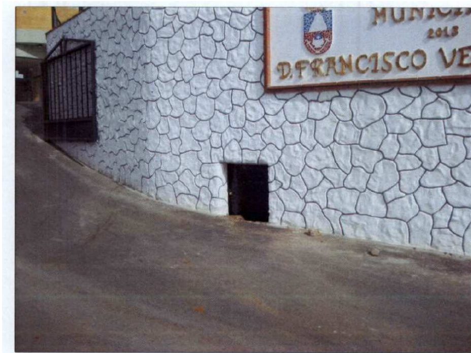
Fotografía nº 6.- Manantial SALUD 18: Elemento de acceso y protección.
