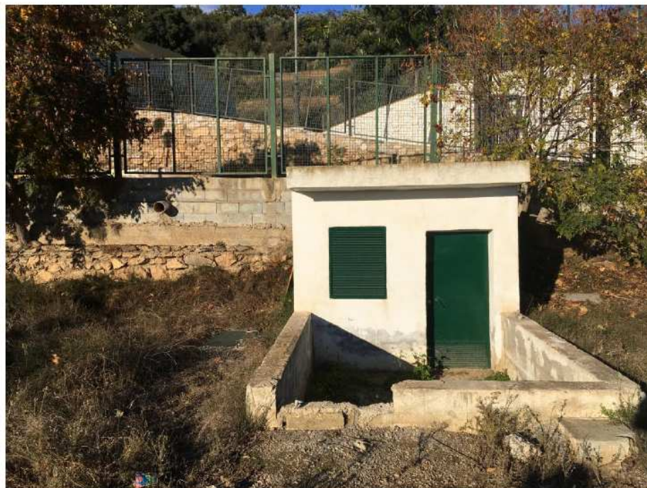
Figura 1.1.- Caseta protección Manantial de San Vicente
