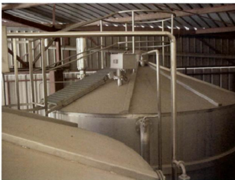
Fotografía 10. Detalle de la parte superior del Depósito de Recepción.
