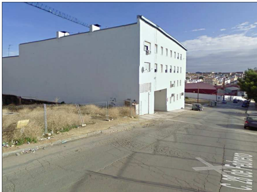
Vista Fachada a calle 28 de Febrero
