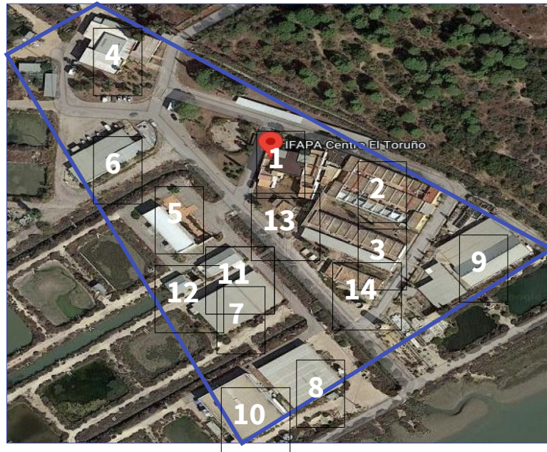
Vista aérea de las edificaciones en la instalaciones del Centro IFAPA El Toruño
