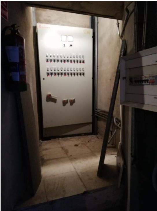
Sala de instalaciones C
