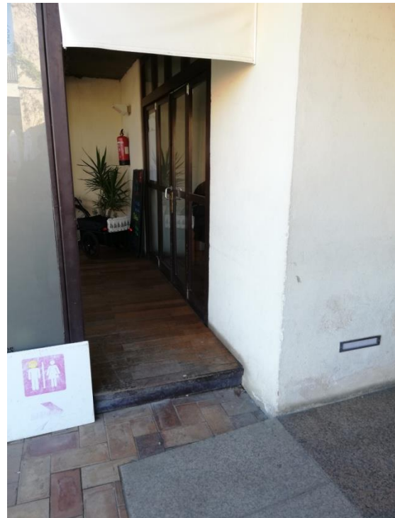
Acceso a terraza cubierta de bar
