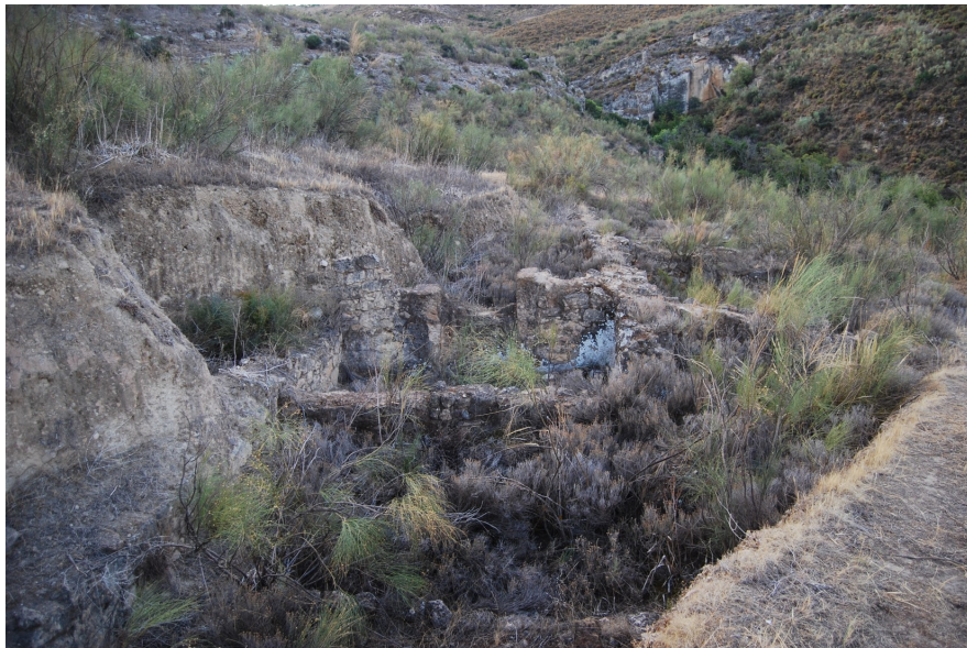
ANTES DE LA LIMPIEZA
