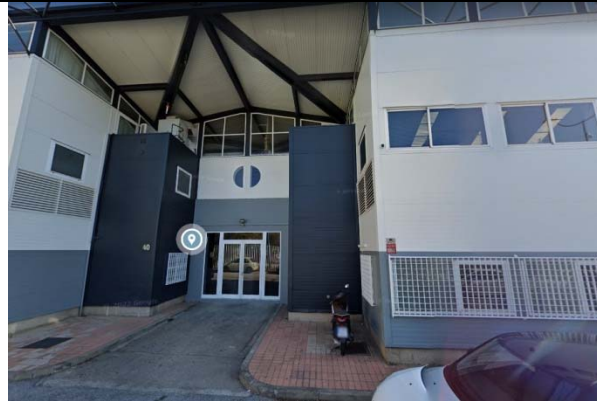
FACHADA POSTERIOR C/TORRICELLI
