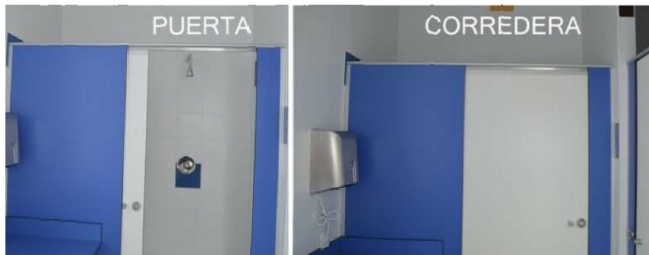
DETALLE PUERTA CORREDERA EN CABINA FENÓLICO ASEOS
